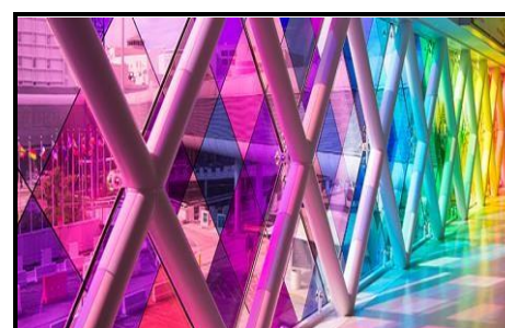
Figure 165. vitrage teinté avec film
