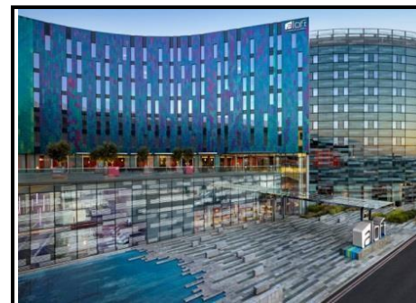
Figure 164. Façade avec un vitrage teinté
