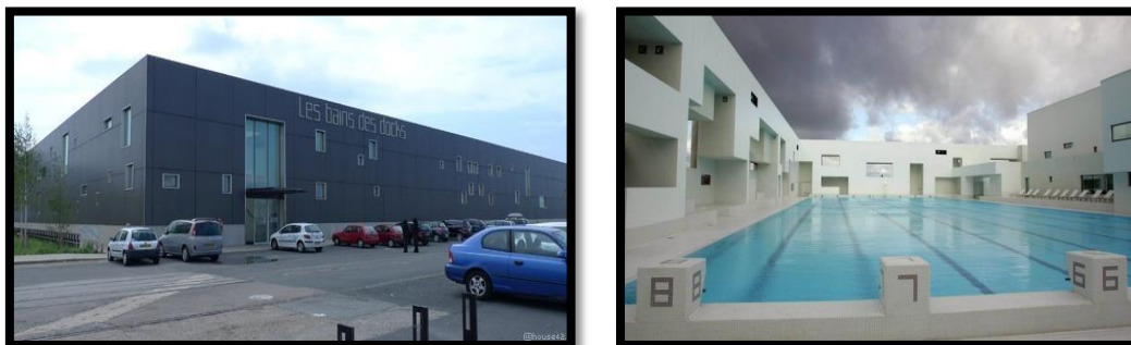
Figure 13. Le centre aquatique Docks
