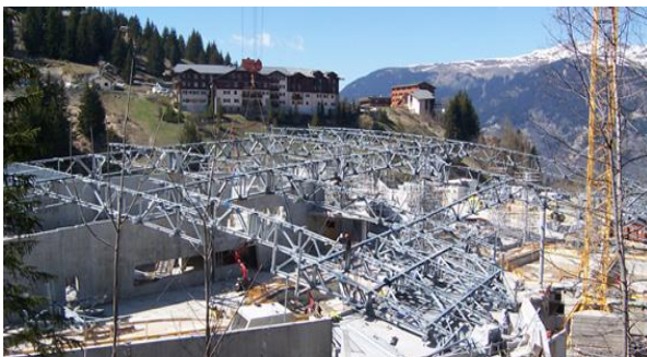
Figure 103:la mise en place de la structure tridimensionnelle
