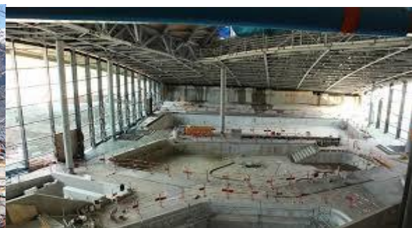
Figure 104:détaille d'intérieur de la structure
