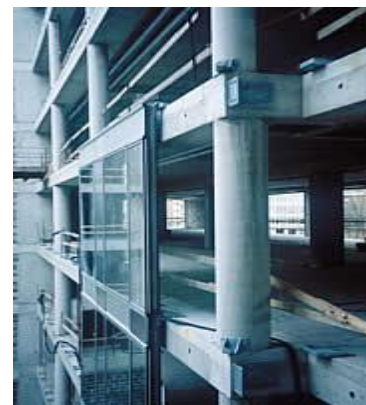
Figure 240: exemple de fixation mur rideau
