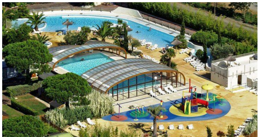
Figure 87:bassins couverts avec une structure pliante (fonctionnant en toutes saisons).
