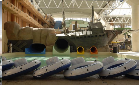
Figure 129:vue intérieure qui montre la structure de toiture
