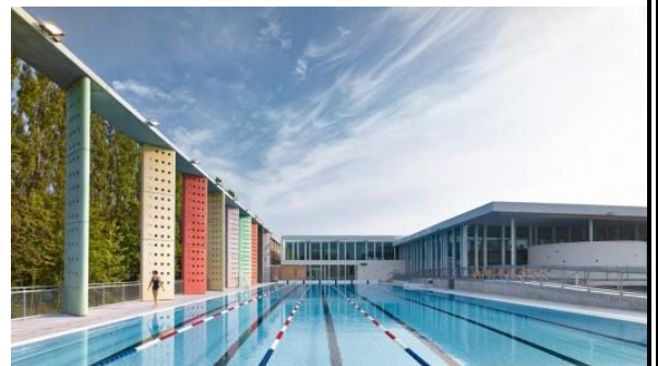
Figure 72:le centre aquatique de louviers
