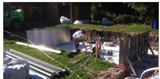
Figure 262: bassin en Inox
