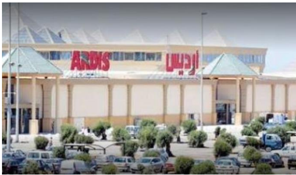
Figure 130:vue montre les coques vitrées sur la Source : www. Ardis .dz
