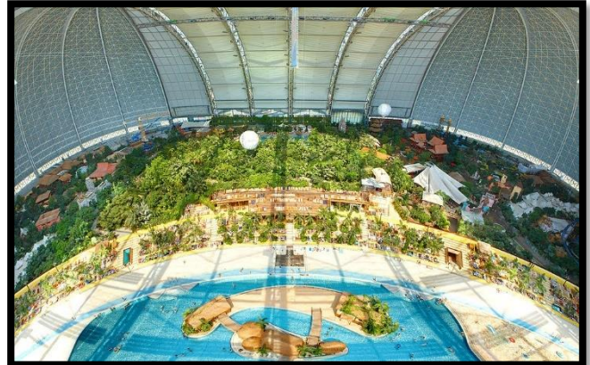
Figure 108:vue d'intérieur du PARC
