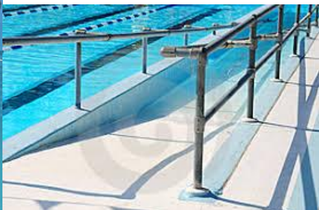
Figure 183:Illustration d'un escalier d'accès à L'eau avec Une double main-courante de chaque côté
