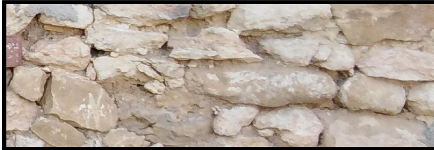
صورة رقم (106): إستعمال التربة البيضاء و الماء كملاط بمسجد الزاوية- من تصوير الطالب-
