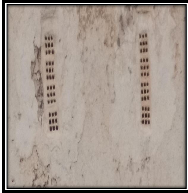
صورة رقم(80): تقنية التشبيك بواسطة الآجر في مسجد بني زهنة -من تصوير الطالب-
