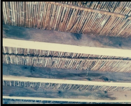
لوحة رقم (87) : الجمع بين عدة أنواع من الخشب في سقف واحد- من تصوير الطالب-
