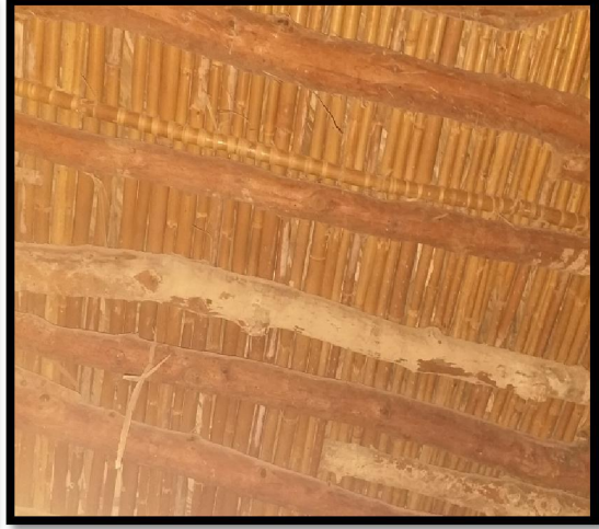
لوحة رقم (86): إستخدام القصب و الأخشاب المصنعة أو الطبيعية كعوارض بمسجد البوحميدي - من تصوير الطالب-
