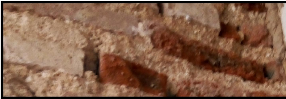
صورة رقم (107): إستعمال التربة البيضاء و الماء كملاط بمسجد سيدي يعقوب- من تصوير الطالب-
