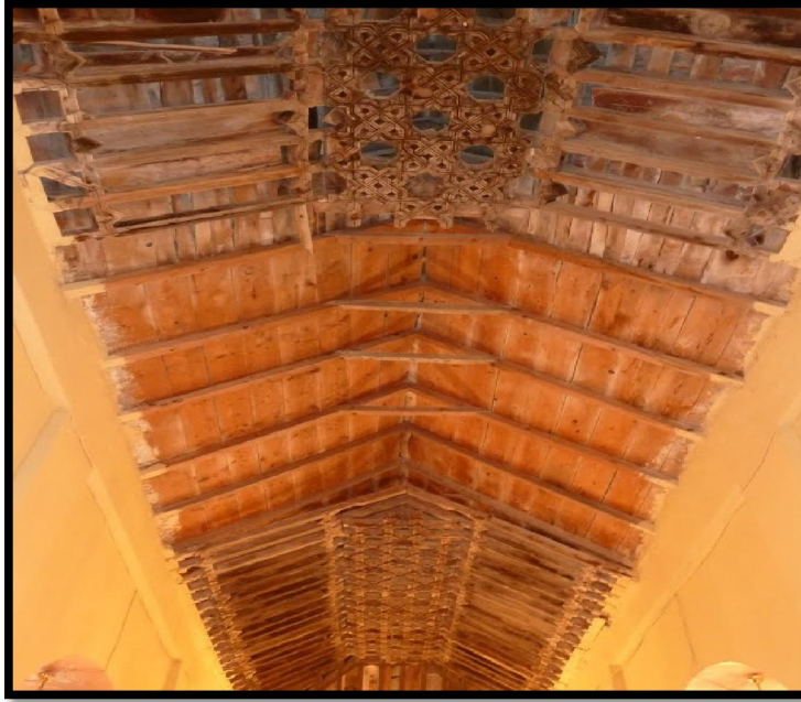
صورة رقم (112): السقف الخشبي الجملوني بمسجد سيدي يعقوب - من تصوير الطالب-
