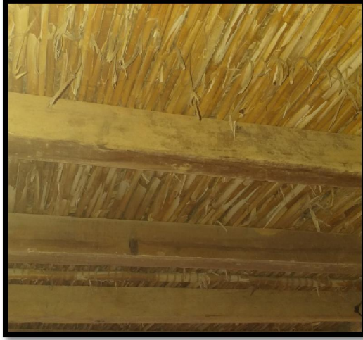
لوحة رقم (86): إستخدام القصب و الأخشاب المصنعة أو الطبيعية كعوارض بمسجد البوحميدي - من تصوير الطالب-
