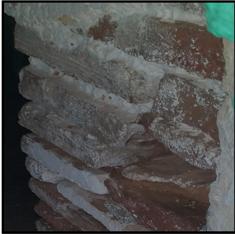
صورة رقم (125): إستعمال تقنية المزج بين الحجارة والأجر في ضريح سيدي عامر الصغير-من إعداد الطالب-
