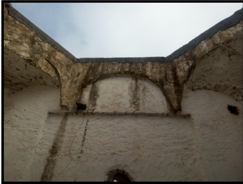
صورة رقم ( 51 ) : العقود المصمطة في بضريح سيدي البشير -من تصوير الطالب-
