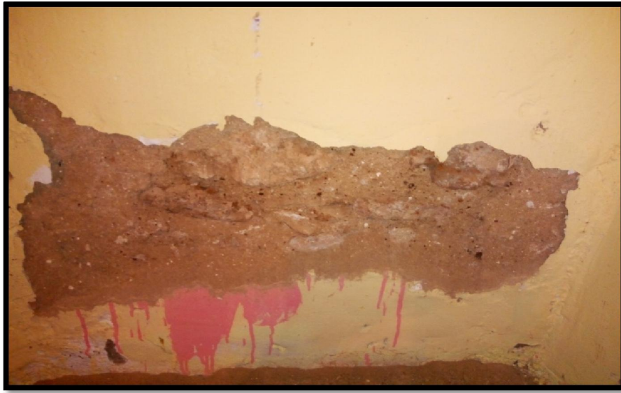
صورة رقم(120) : إستخدام تقنية الطابية في مسجد سيدي يعقوب –من تصوير الطالب-
