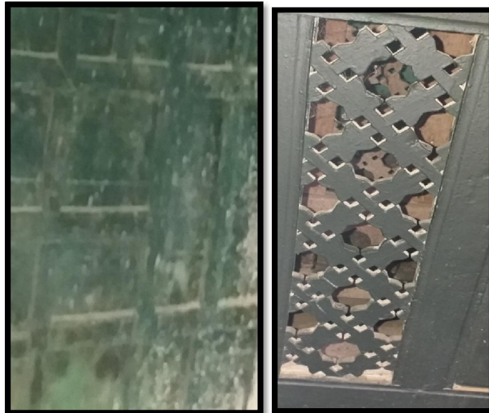
لوحة رقم (91): تقنية النقر و اللسان في تعشيق و تجميع القطع الزخرفية بتابوت ضريح سيدي عامر الصغير (على اليمين) و ريشتا منبر سيدي المداني - من تصوير الطالب-
