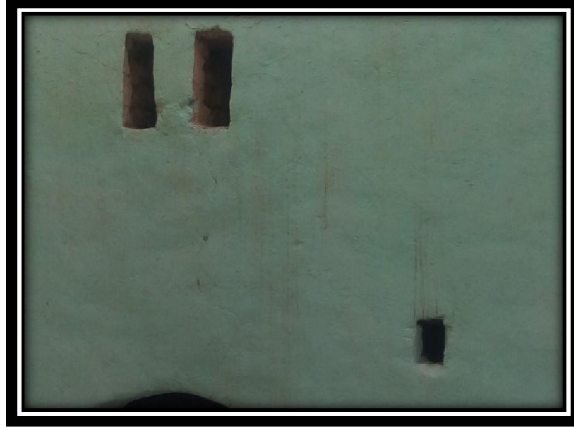
صورة رقم (74) : نوافذ ضريح سيدي احساين -من تصوير الطالب-
