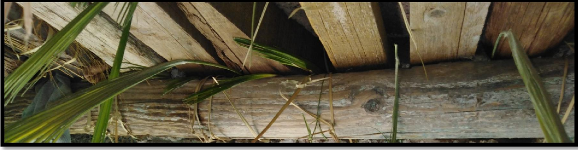
صورة رقم (111): إضافة سعف النخيل إلى العوارض الخشبية المصنعة أو الطبيعية مكان القصب في ضريح سيدي رحمون - من تصوير الطالب-
