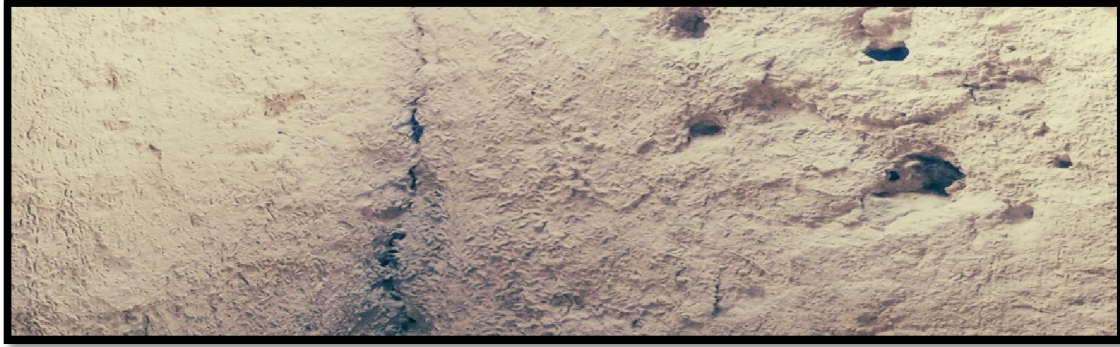
صورة رقم (109) : تليس الجدران الداخلية لمسجد سيدي دحمان بالمونة- من تصوير الطالب-
