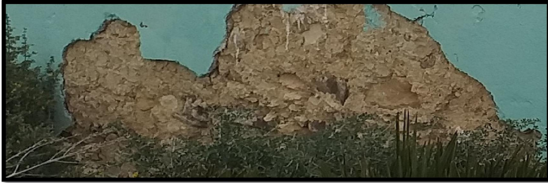
صورة رقم (110) : تليس الجدران الخارجية لضريح أولاد إبراهيم العامري بالمونة- من تصوير الطالب-
