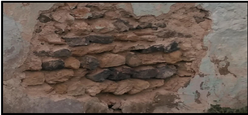
صورة رقم (124): البناء بتقنية السنبلة في ضريح مولاي اعمر بالشهابنة - من إعداد الطالب -
