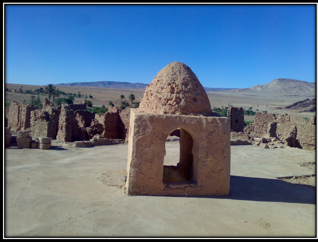
صورة 03: قبة المسجد قبل عملية الترميم
