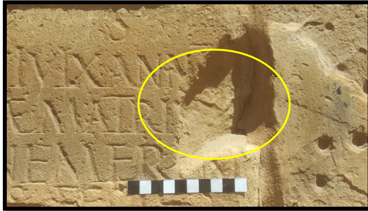
الصورة رقم: 28 تفتت الحجارة.
