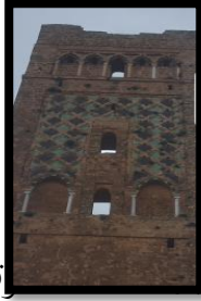
الصورة رقم: 49 توضح تقنية البناء بالحجارة المنتظمة
