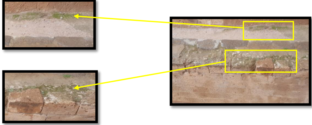
الصورة رقم: 71 توضح تشكل الطحالب على الحجارة.
