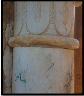
الصورة رقم: 52 وجود النمل والصورة رقم: 53 ظهور الكتابة الصورة رقم: 54 تآكل الرخام
