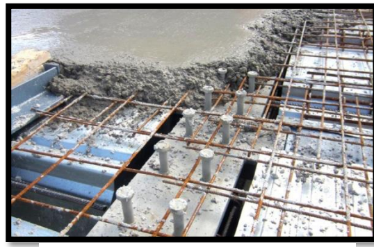
Figure 157 : Modèle d'un plancher collaborant 159
