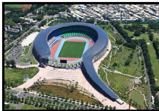
Figure 16: Stade national de Kaohsiung(Taiwan) 10
