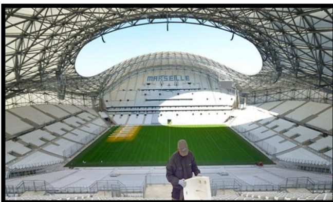
Figure 21: Toiture de Stade Orange-V lodrome 12
