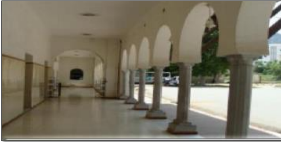
Fig. II.55 : La galerie d'entrée
