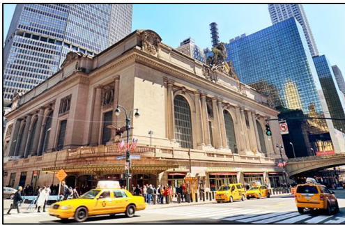
Fig. I.11 : La gare de New York – Etats Unis Source : www.cnewyork.net
