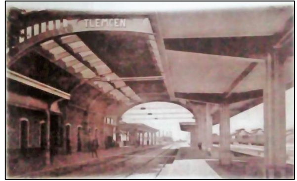
Fig. II.48 : La gare de Tlemcen en 1945
