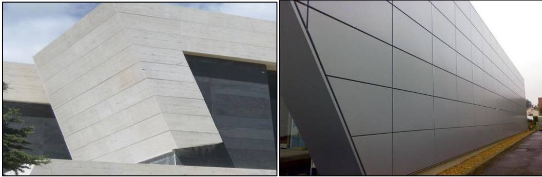
Fig. III.39 : Bardage métallique et de marbre
