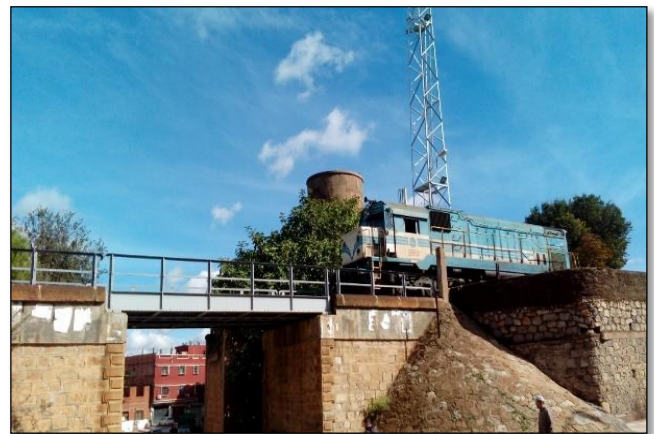
Fig. II.19 : pont de chemin de fer Source : Auteurs
