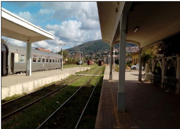
Fig. II.18 : La gare ferroviaire de Tlemcen Source : Auteurs
