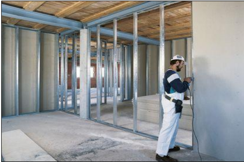
Fig. III.41 : Squelette d'une cloison amovible (Une mise en œuvre facile et rapide)
