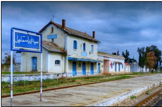
Fig. I.26 : Quai d'une gare – Tunisie
