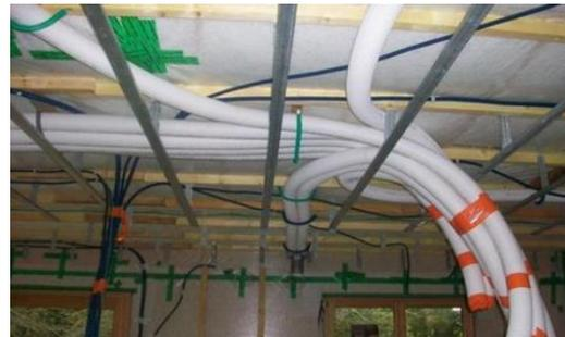
Figure 207 : le passage des gaines techniques dans le faux plafond.
