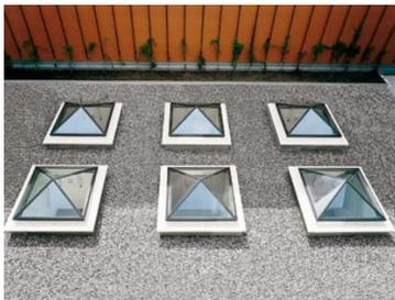
Figure 216 : éclairage Zénithal
