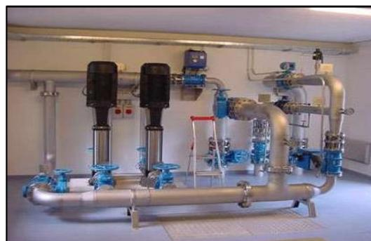
**Figure 184 :** station de pompage et de filtration.
