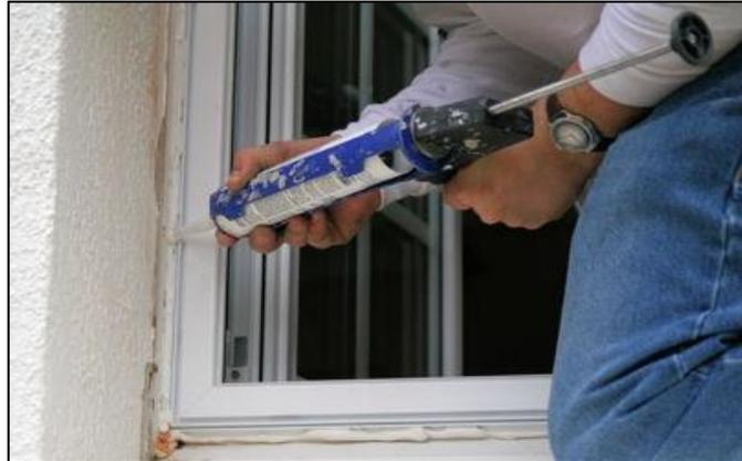
Figure 212 : Isolation des ouvertures par des joints en silicone.
