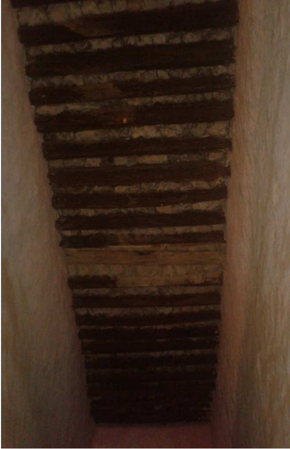
صورة 45: توضح استعمال جذوع النخيل في تسقيف مخزن السلاح
