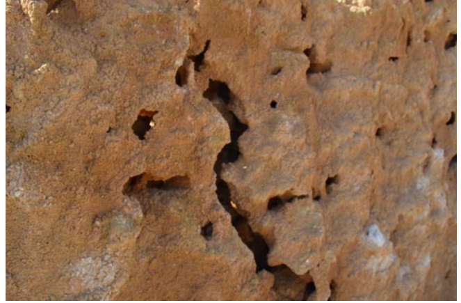
صورة 60: توضح تبلور الأملاح بفعل الأمطار بمخزن السلاح.
