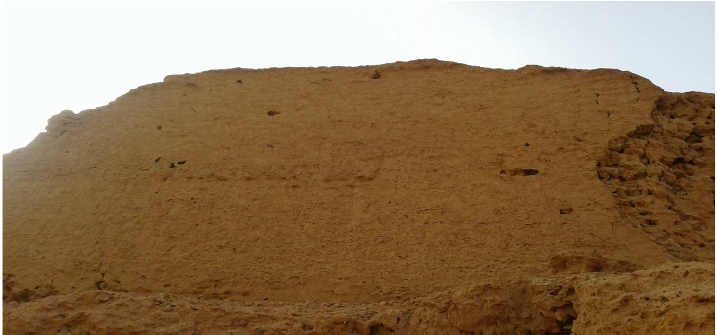
الصورة 09: صورة توضح السور الشرقي لقصبة تايلوت.
