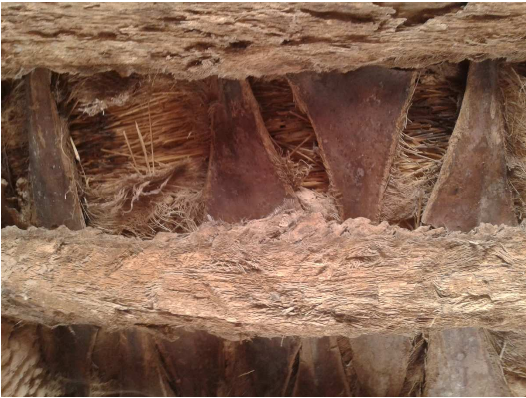
صورة 48: توضح مكونات السقف الكرناف والليف وسيقان القمح استعمال في مخزن السلاح.
