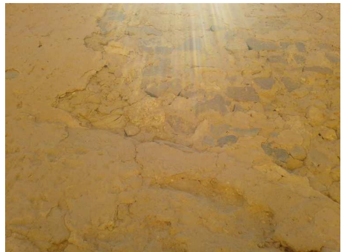
صورة 58: توضح تأثير تغلغل مياه الأمطار في التلييس.
