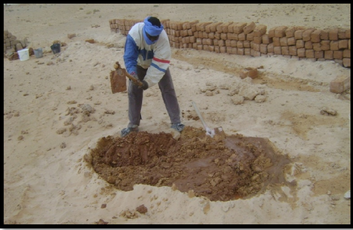
صورة 43: توضح تحضير الطين لعملية البناء.
