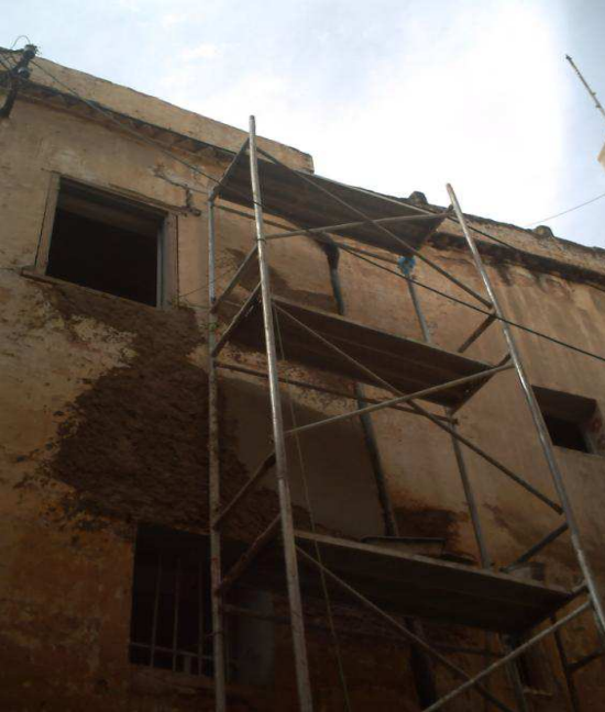
صورة 67: تمثل الصقالات القائمة المستعملة في الترميم.
