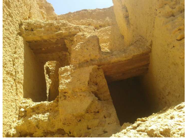
صورة 54: تمثل تقنية بناء سلم البرج الجنوبي للمخزن.
