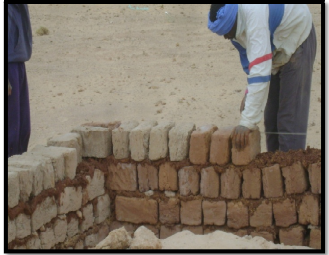
صورة 44: توضح استعمال الطين في عملية الربط بين الطوب.
