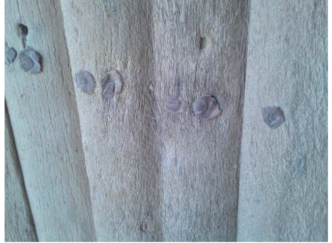
صورة 50: توضح استعمال مسامير من معدن الحديد لربط أجزاء وعناصر الباب الخشبي لقصة اولاد امحمد.
