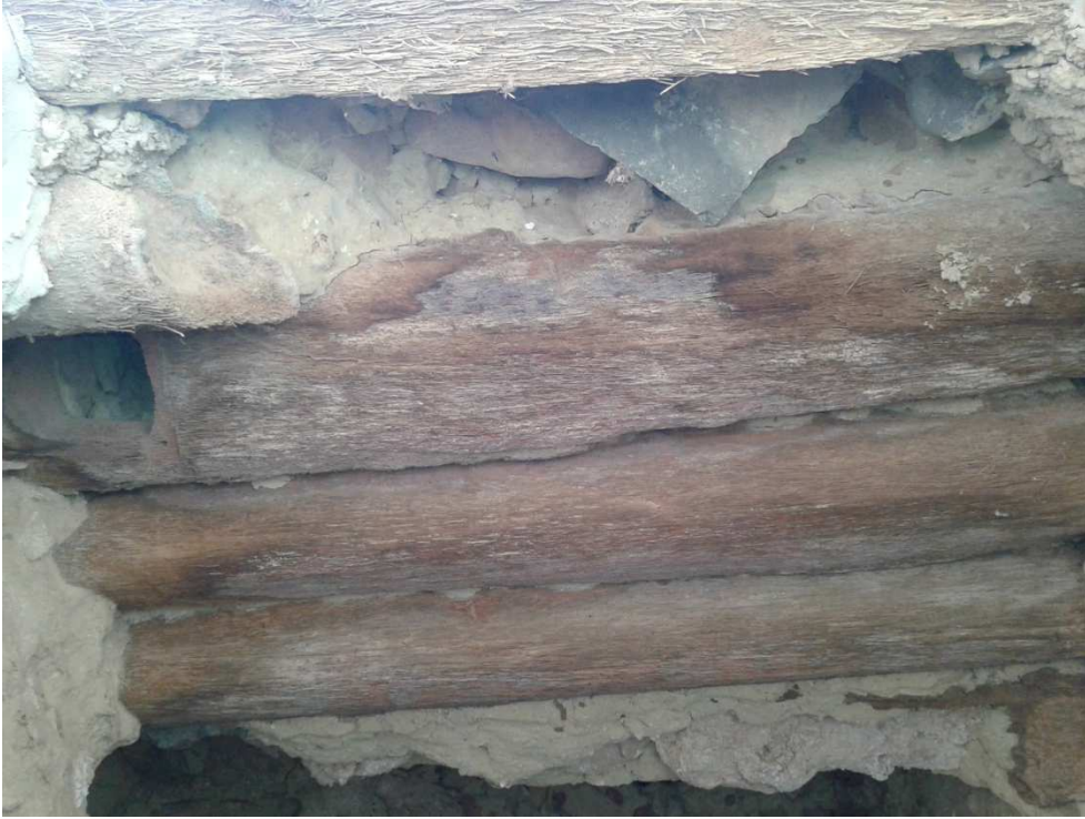
صورة 47: توضح استعمال جذوع النخل لحمل جدار المدخل لمخزن السلاح.
