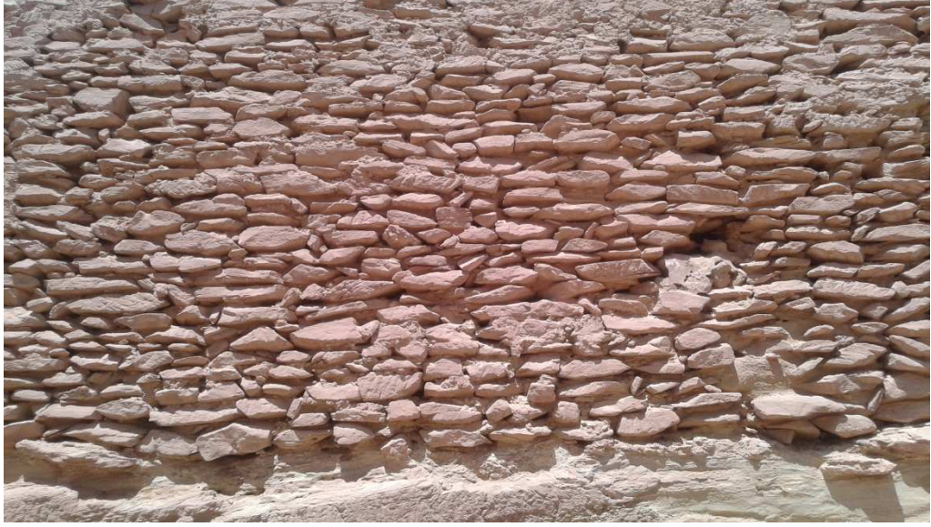
صورة 38: صورة توضح استعمال الحجارة الصلبة في سور قسبة اولاد يعقوب.
