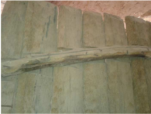
صورة 50: توضح استعمال مسامير من معدن الحديد لربط أجزاء وعناصر الباب الخشبي لقصة اولاد امحمد.
