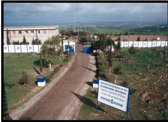
Fig. 11 : Station de Dzioua
