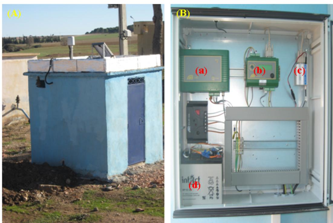
**Figure I.9** – Station hydro-pluviométrique automatique sur l'Oued Tadjemout (affluent de l'Oued Mekerra) : **(A)** : l'abri de station **(B)** : Unité de mesure (**a** : appareil de mesure de débit, **b** : appareil de mesure de pluie, **c** : modem de transmission GSM et **d** : batterie d'alimentation)
