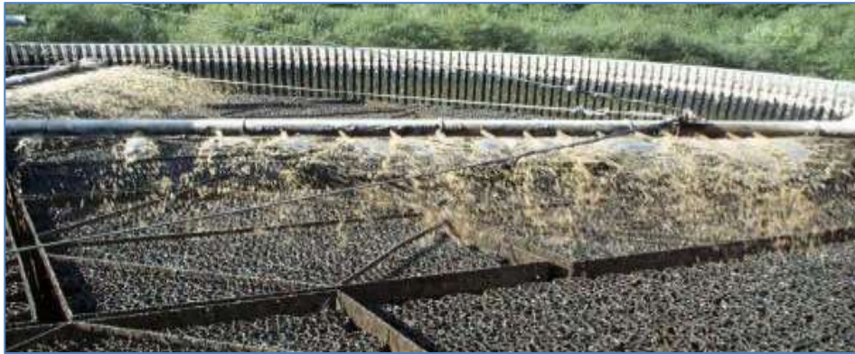
Figure II.3: Alimentation du lit bactérien (garnissage plastique) [60]
