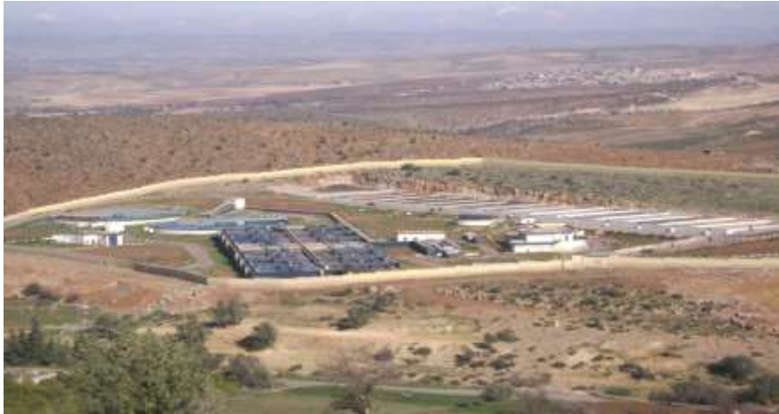
Figure I.5. Panoramique de la station d'épuration des eaux usées de la ville de Tlemcen [46]
