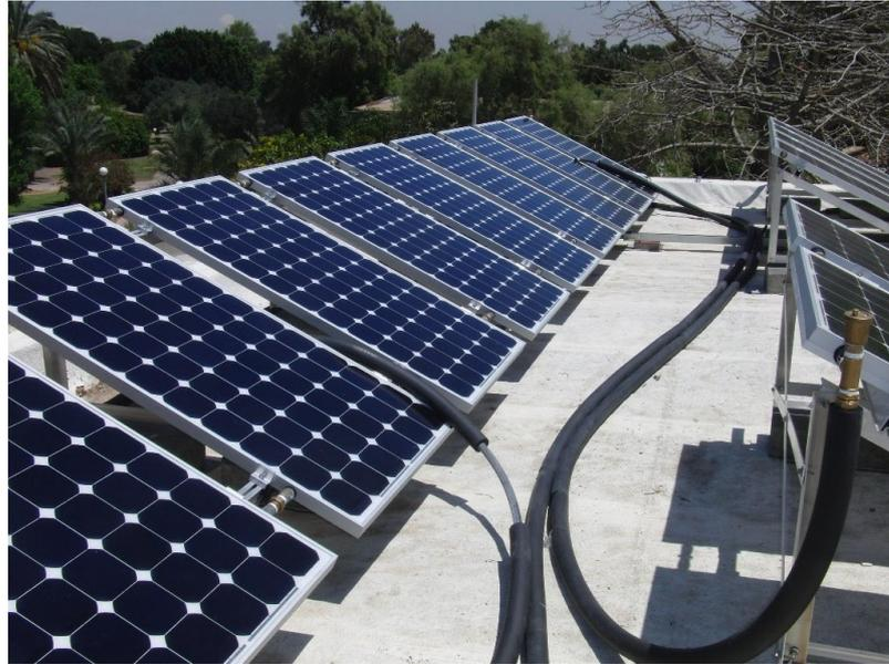
*Figure I. 7 : Capteurs hybrides PV-T*
