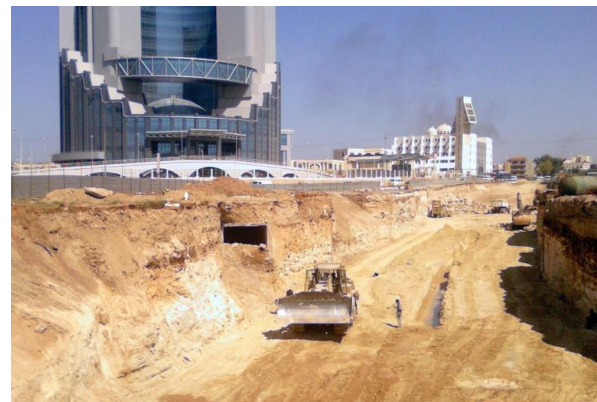
Figure 5.25 Travaux de la STARR [6]
