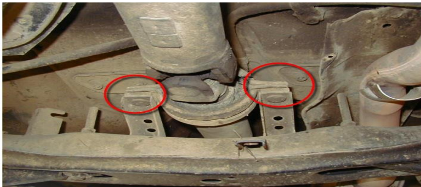
Figure II.9 : retraitage des deux boulons et rondelles.
