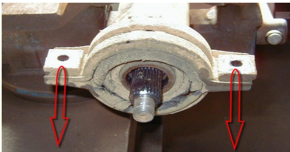
Figure II.17 : Enlèvement du palier central.
