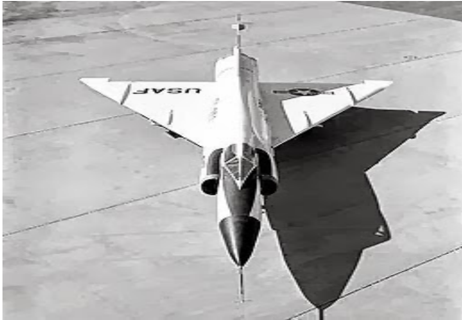
Figure 1-4- Taille de guêpe du Convair YF-102 après les modifications conseillées par Richard Whitcomb qui redécouvrit la loi des ailes brevetée durant la guerre par la société Junkers [10]
