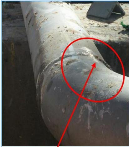
Photos V. 3 : Rupture de la soudure.
