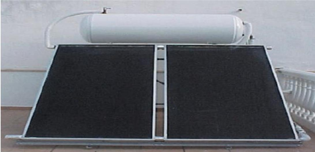
Figure III.4 Capteur plan à eau
