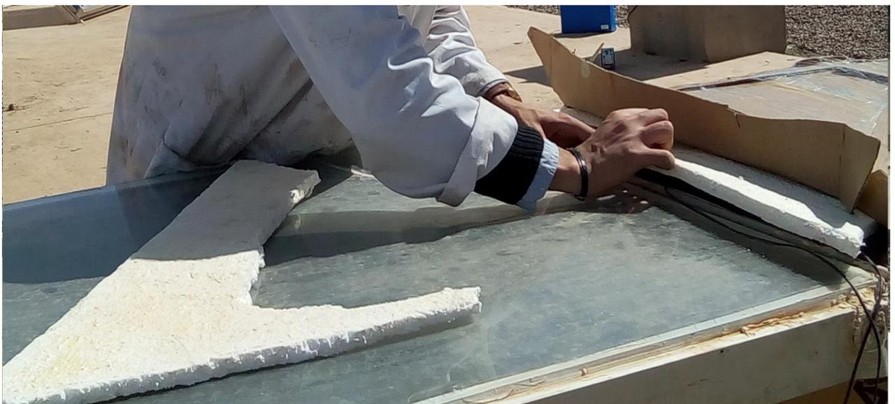
**Figure IV.5 Placement de l'isolation (polystyrène)**
