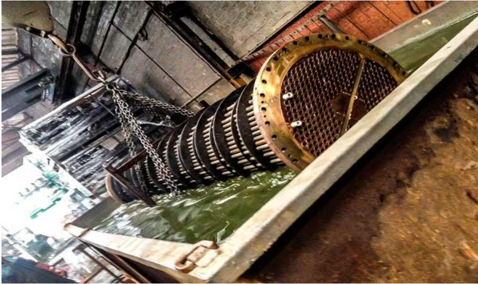
Figure III.4 : Nettoyage chimique (image réelle)
