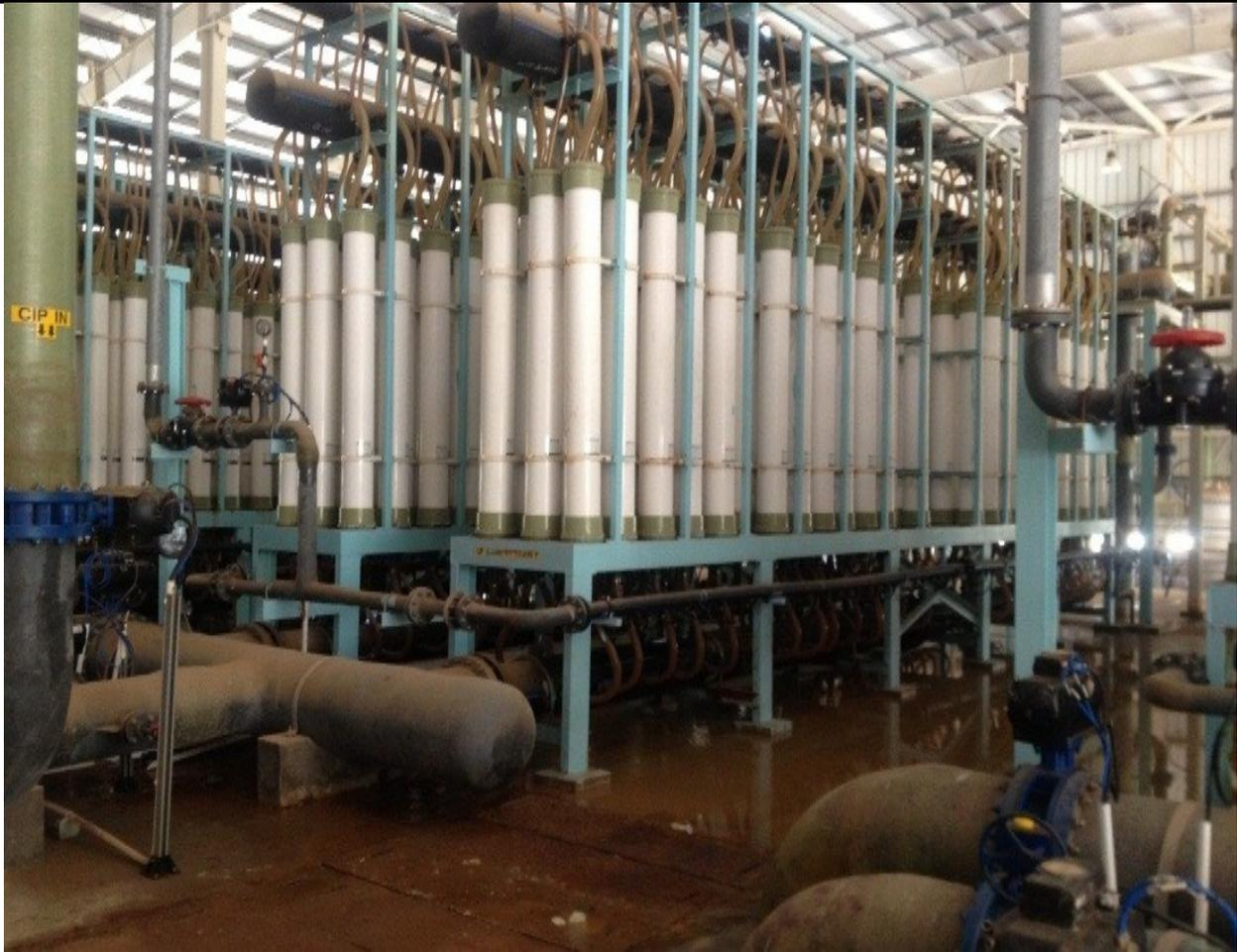
*Figure 7 Les trains de l'Ultrafiltration*
