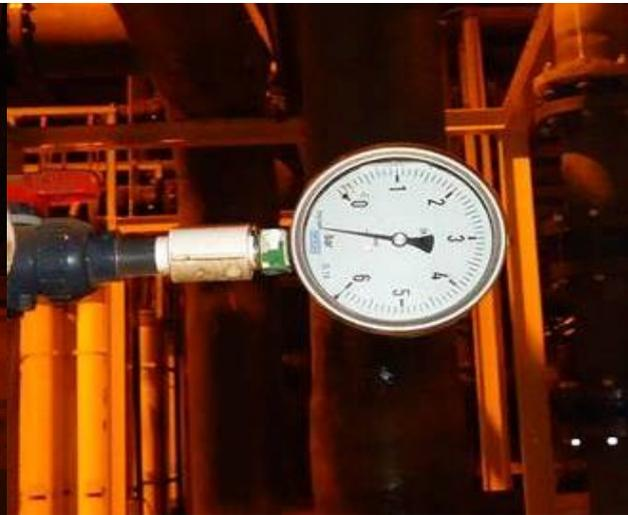
*Figure 59 Manomètre du perméat*
