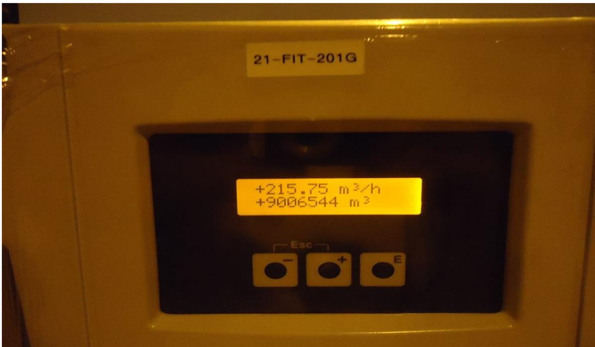
*Figure 63 Débitmètre du perméat*
