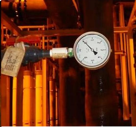
*Figure 62 Manomètre du perméat*
