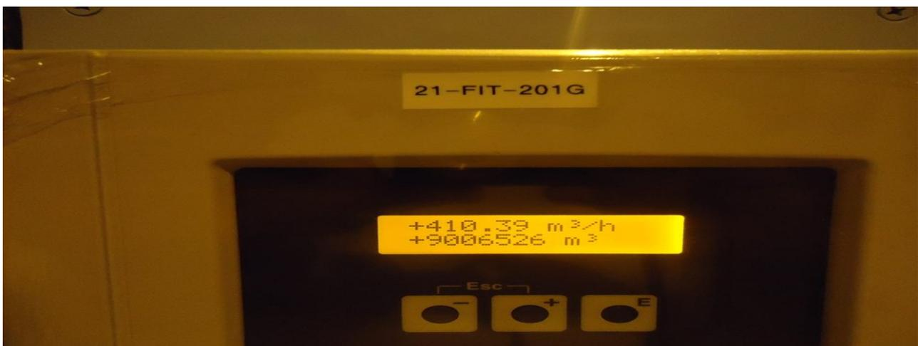
*Figure 60 débitmètre du perméat*
