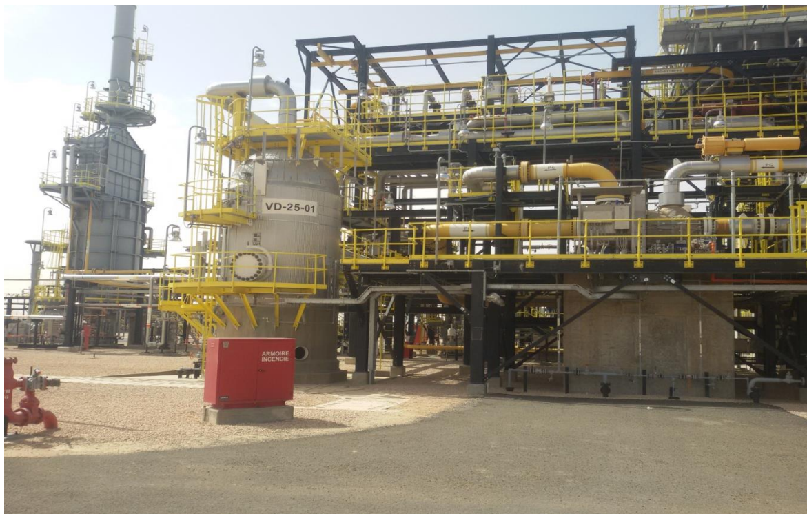
Figure I.7 : Usine CPF de la région de Rhourde Nouss [25]
