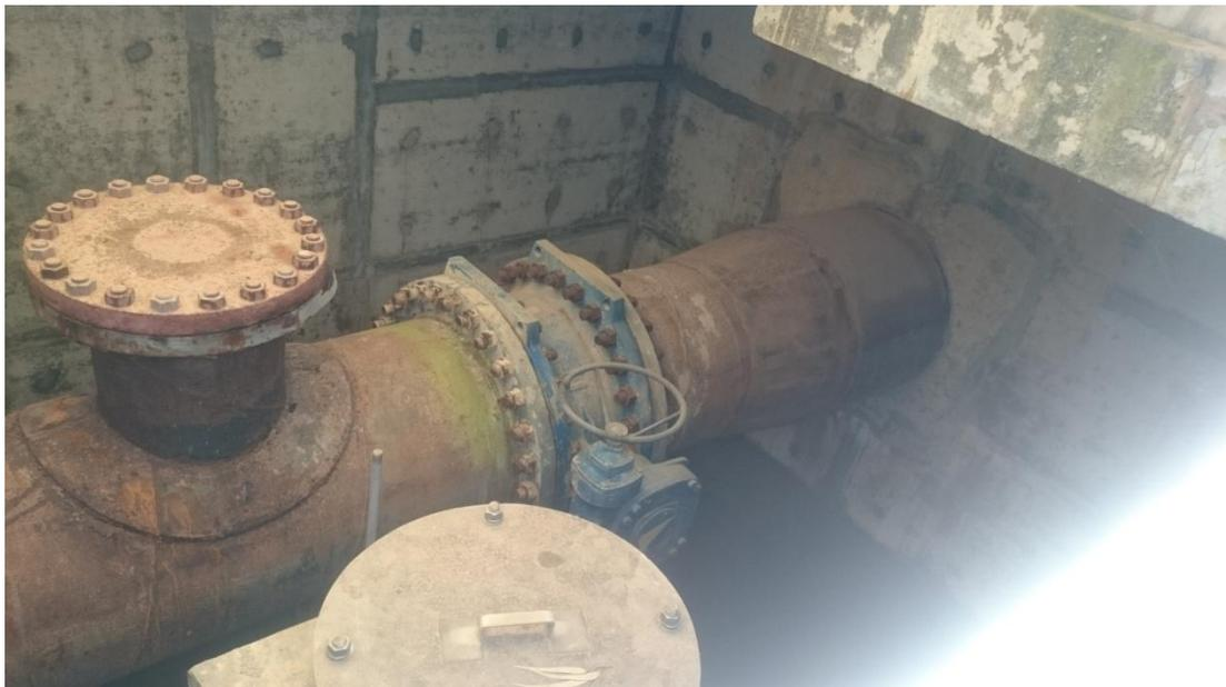
Figure II. 37 : Tuyau en fonte
