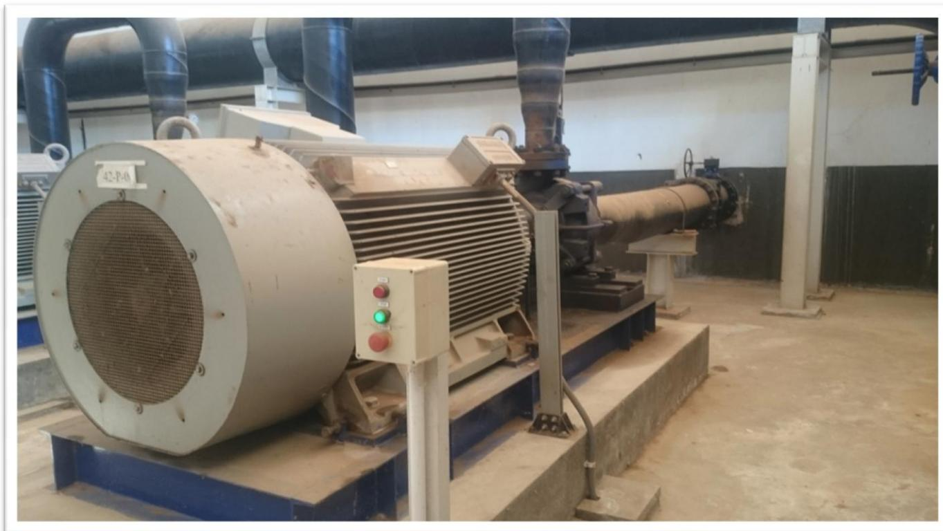
**Figure II.20 : Pompe centrifuge de la Station de pompage de Souk-Tleta**
