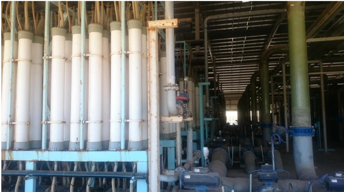
**Figure I .12 : Salle d'ultrafiltration (les trains)**
