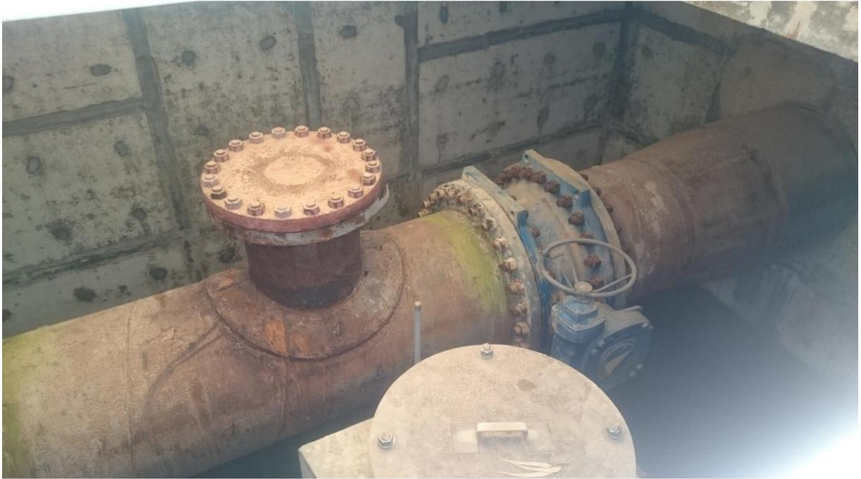
**Figure I.17: Conduite de refoulement en fonte ductile DN 1000**
