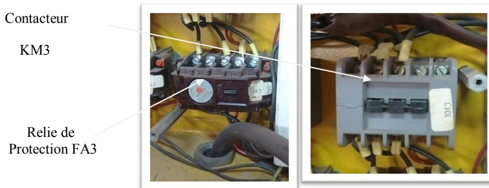
Figure III.13 : Contacteur et relie de protection endommagés
