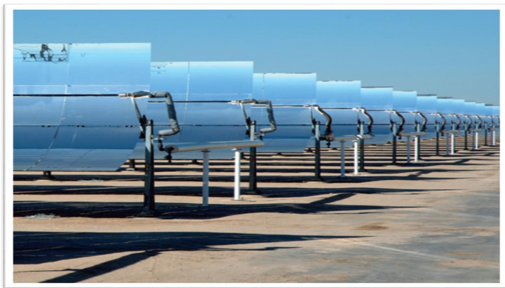
Figure (II.2) : Centrales à collecteurs cylindro-paraboliques
