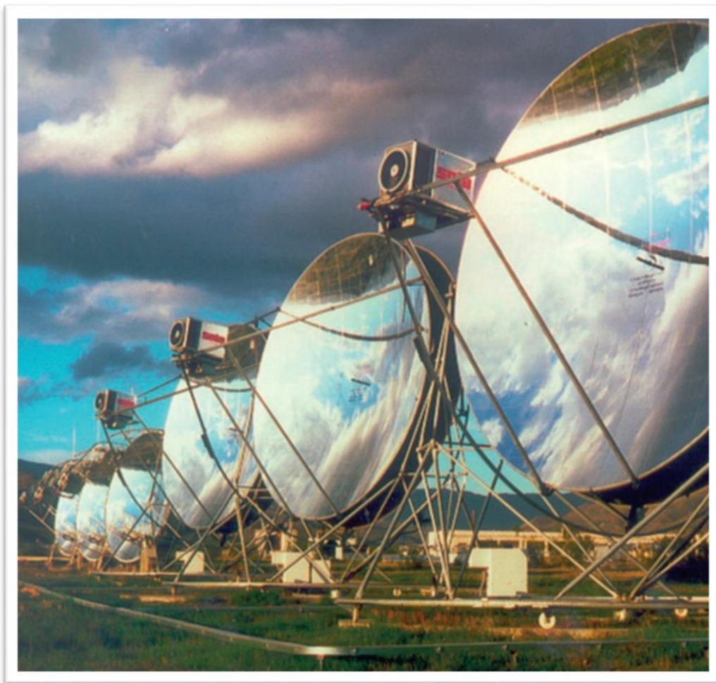
Figure (II.5) : Centrales à capteurs paraboliques
