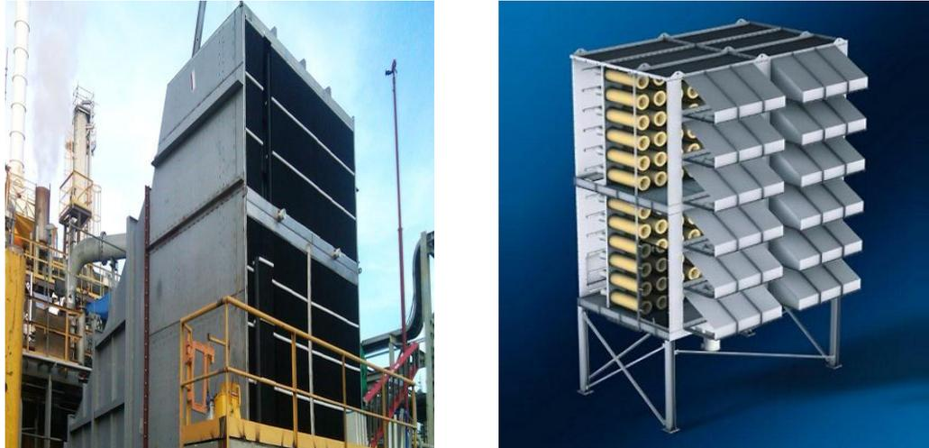
**Figure (IV.3) :** filtre d'air de la Turbine MS5002C
