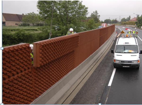
**Fig. II. 27 :** *Un mur anti-bruit de nature fractale pour réduire les bruits sonores des voitures*
