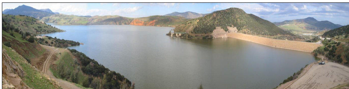
Fig. III.1- Photo du barrage Hammam Debagh ; cliché ANBT.
