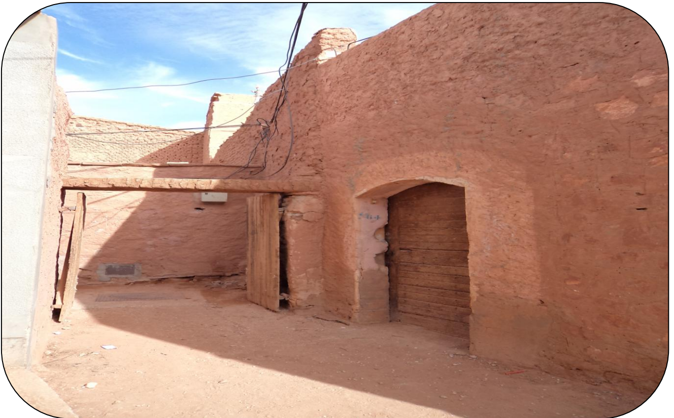
الشكل -03- المدخل الثاني للقصر
