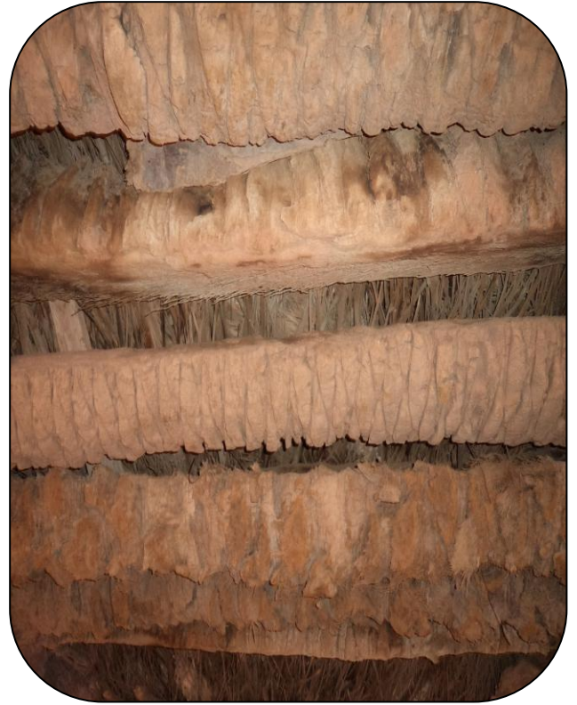
طريقة بناء السقوف في القصر
