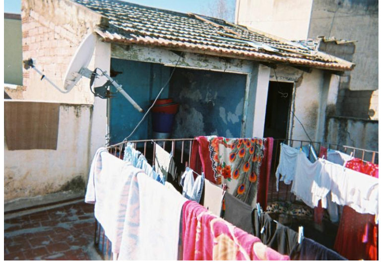
لوحة رقم ( 43 ) الجهة الجنوبية للسطح
