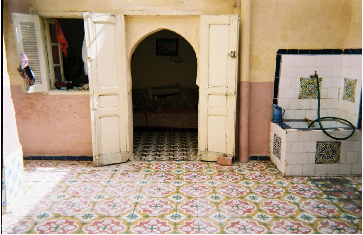
لوحة رقم (17) غرفة بالطابق الأرضي في الجهة الشمالية للدار
