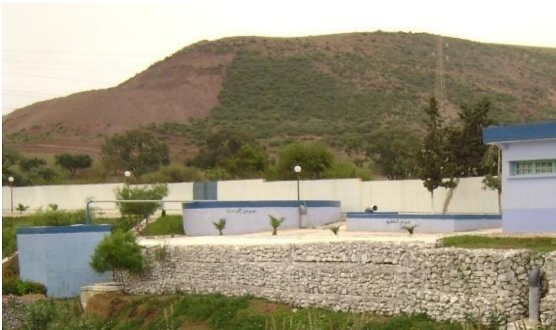
**Figure 21 : Bassin de Décantation + bassin de désinfection du lagunage Amir Ebdel Kader (Chachoua, 2010)**
