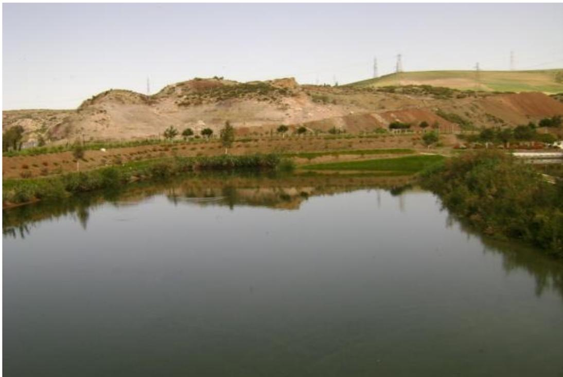
**Figure 20 : Bassin de maturation du lagunage Amir Ebdel Kader ( Chachoua, 2010)**
