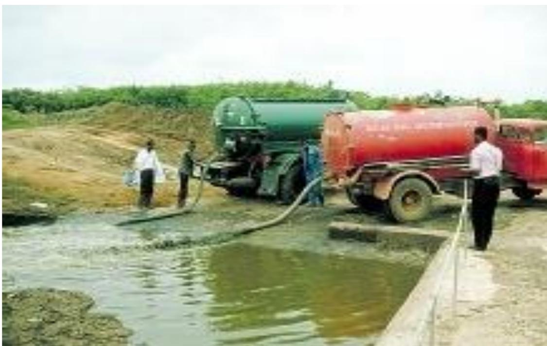
**Figure 4 : Curage d'un bassin (Cemagref, 2004)**
