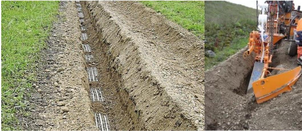
Figure (I. 17) : Réseau de capteurs pour les digues du Rhin entre Strasbourg et Iffezheim [Captiven 2014]
