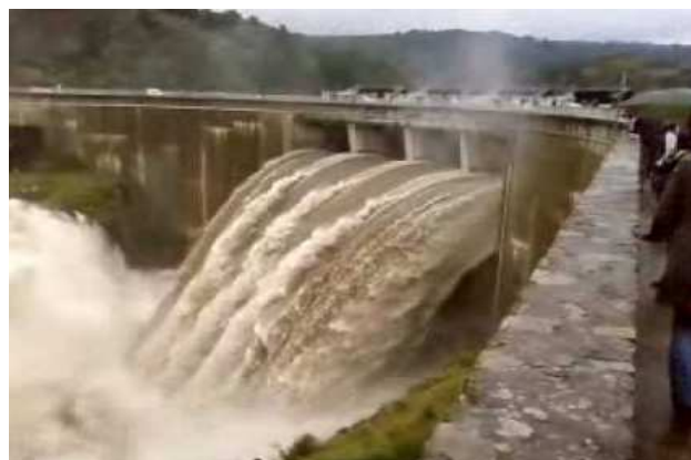
Figure I.10: Evacuateur de crue du barrage Grangent France. (youtube.com)
