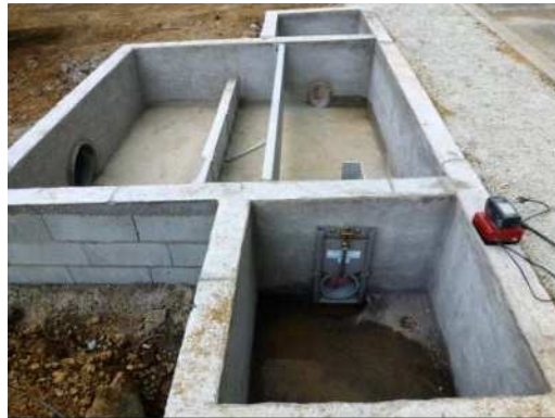
Figure I.9: Déversoir d'orage. (hydroconcept.fr)
