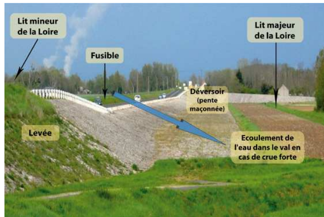
Figure 1.11: déversoir d'endiguement de protection contre les inondations.
