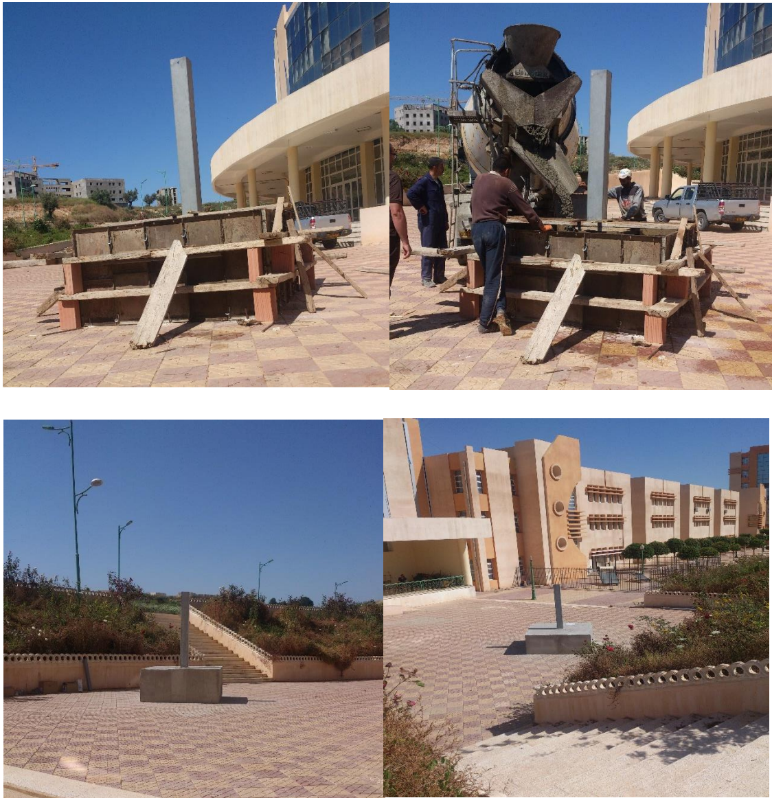
Figure 3.32 – Etapes de confection et emplacement de la plateforme de béton
