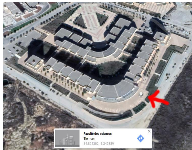
Figure 3.30 - Image satellitaire de la faculté des sciences de Tlemcen montrant l'emplacement du suiveur solaire
