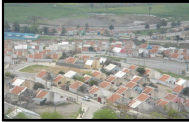
Figure 2-83 : vue extérieure de village
