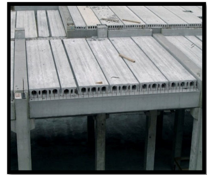
Figure 4-64 : le plancher alvéolaire 316
