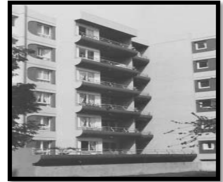
Figure 1-5 : bâtiment préfabriquée en béton
