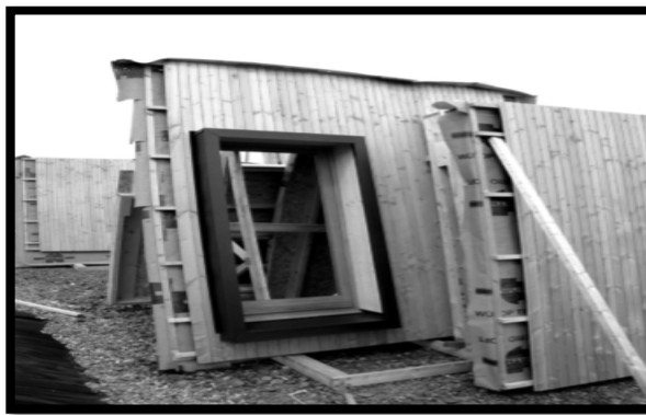
Figure 2-61 : Fabrication des murs en atelier et prototypes des prés cadres et seuils
