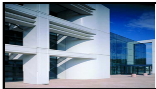
Figure 1-24 :Éléments de façades et de structures préfabriqués en béton blanc poli centre administratif, Toulouse.
