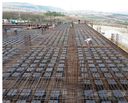
Figure 4-47 : poutrelle colle sur chantier 288
