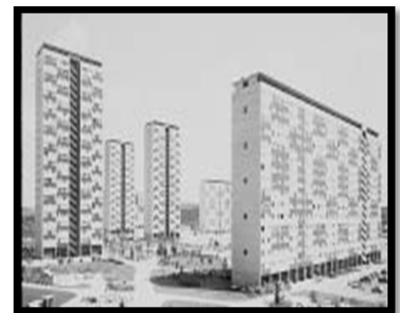
Figure 1-3 : tour préfabriquée en béton
