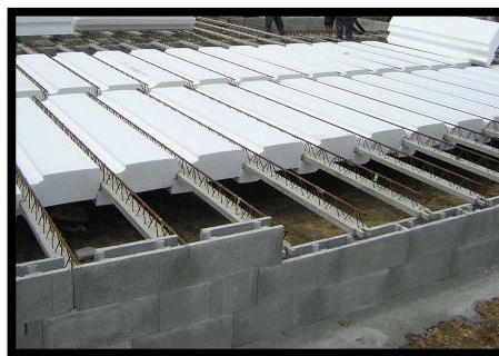
Figure 4-49 : poutrelle en béton de type treillis 293
