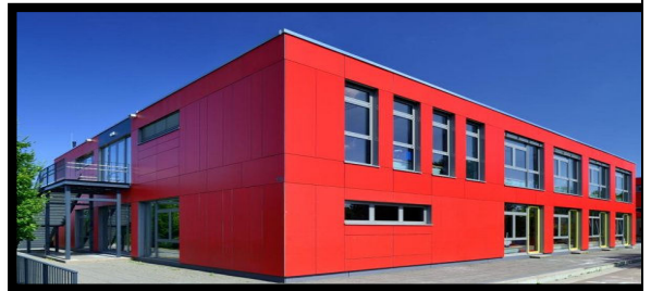
Figure 1-51 : Ecole en construction modulaire à Berchem, Luxembourg : L'école est composée de 19 modules ont été adaptés aux conditions existantes et fabriqués dans l'usine, puis montés et aménagés en seulement sept semaines de temps de construction. 48
