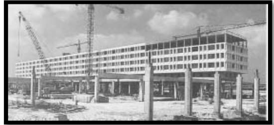
Figure 1-4 : construction préfabriquée en béton
