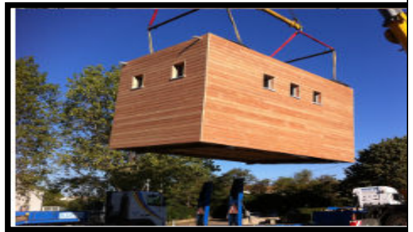
Figure 1-50 : l'installation de module
