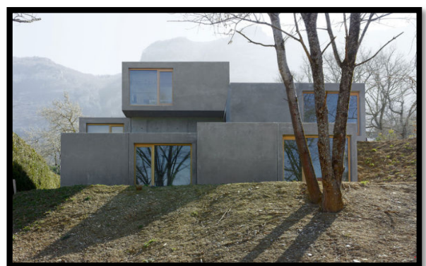
Figure 1-65 : vue extérieure de maison
