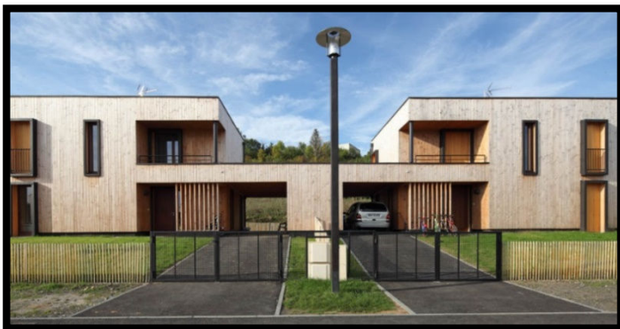
Figure 2-53 : des auvents abritant les véhicules.
