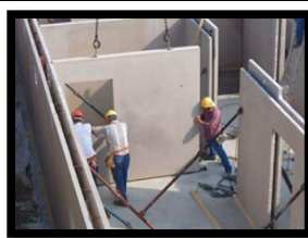
Figure 1-32 : les cloisons de séparation 27
