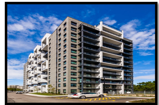
Figure 1-6 : Bâtiment résidentielle en béton préfabriqué à Kitchener Canada
