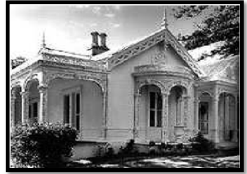
Figure 1-1 : Maison préfabriquées en Écosse et exportées en Australie Corio villa, Geelong, 1856 (Alan Ogg 1987)
