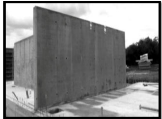
Figure 2-60 : Murs en béton banché
