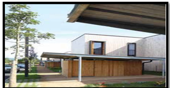
Figure 2-58 : abris pour voitures.
