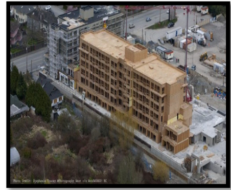
Figure 1-44 : le projet Remy à Richmond en Colombie, qui consiste en trois bâtiments à ossature de bois de 6 étages sur un parking en béton à deux niveaux. 42
