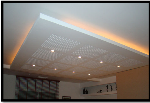
Figure 4-121 : faux plafond suspendu 382
