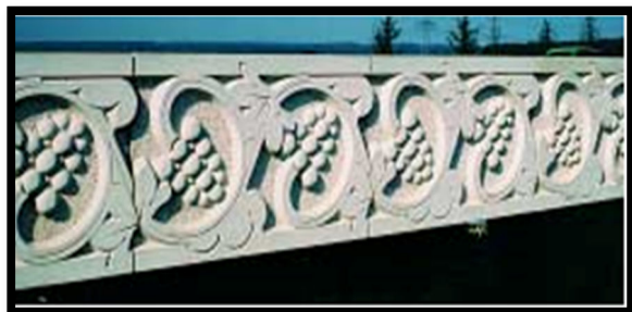
Figure 1-21 : ponts, La Charité-sur-Loire. Garder-corps réalisés en moules élastomère. Skidmore
