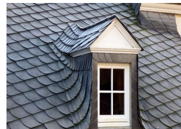
Figure 4-80 : toit en ardoise 329
