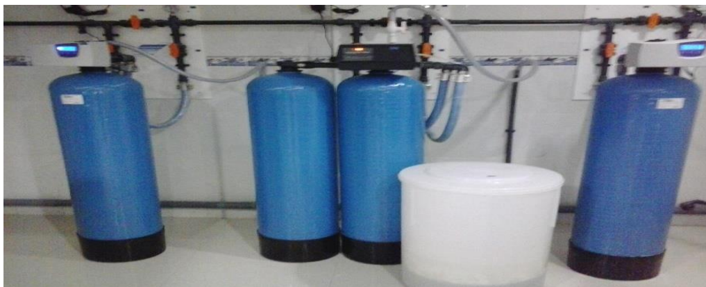
Figure I.9: La chaîne de prétraitement (respectivement du droite à gauche : filtre à sable, bac à sel, adoucisseur, filtre à charbon actif).
