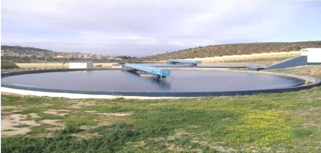
Décanteurs secondaires.
