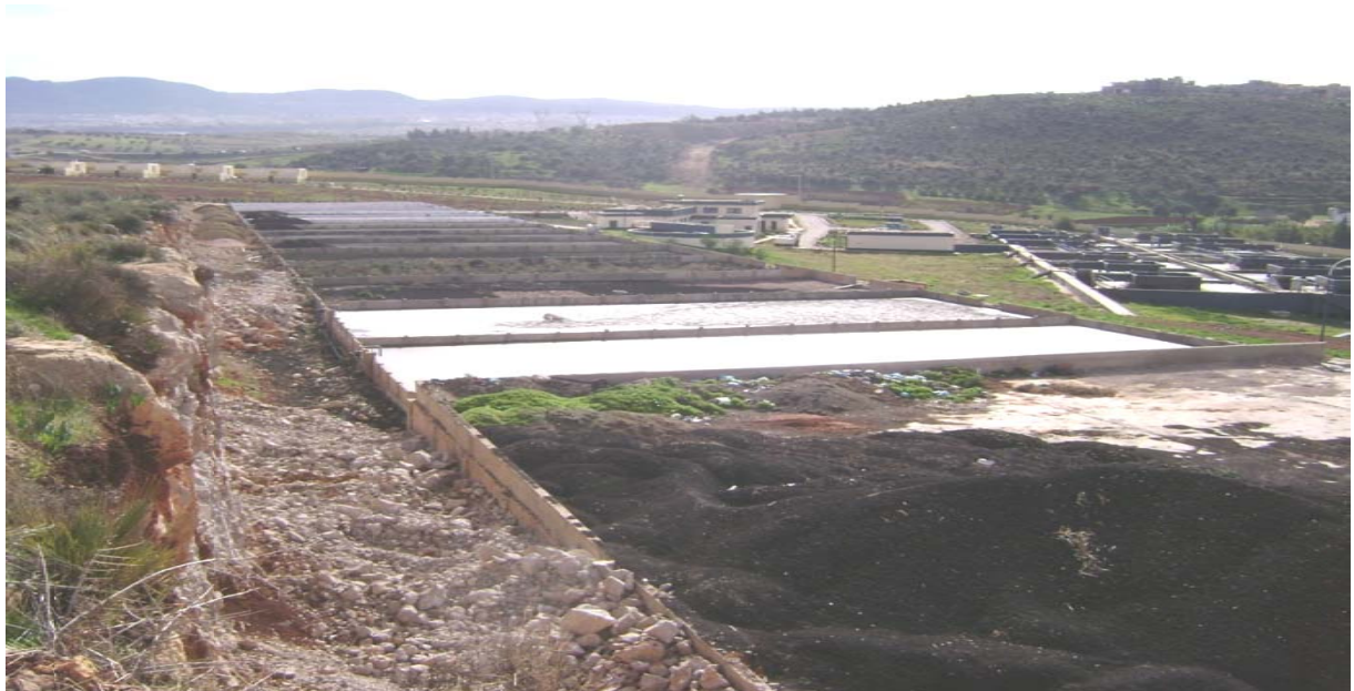
Lits de séchage +Aire de stockage.
