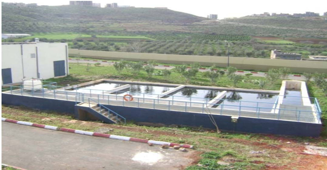
Canal déversoir du rejet du bassin de chloration.
