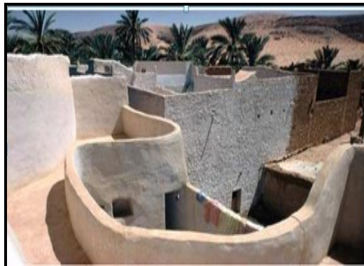
Fig 1-7 : Mur épais a haut inerthie thermique
