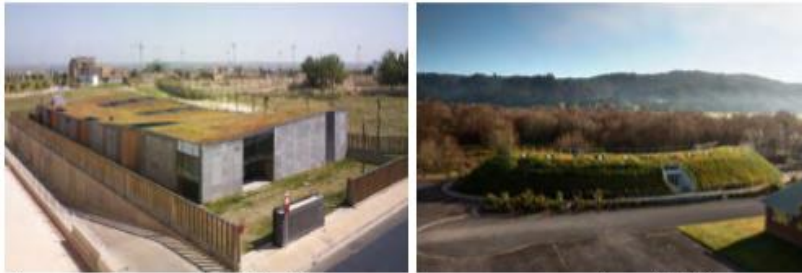
Figure 20: Exemple de toiture végétalisée et de mur masse, Oliver Kindergarten
