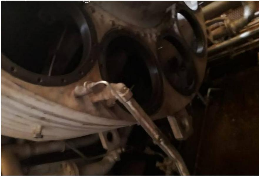
Figure I.6 : Le revêtement externe de la chambre combustion
