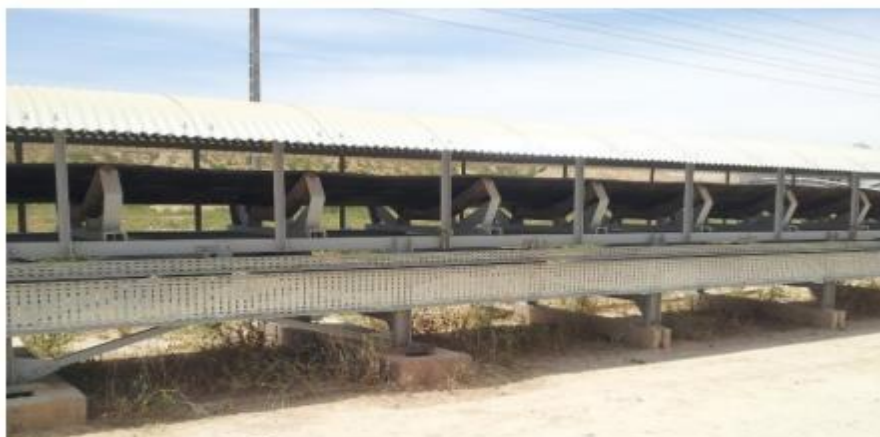
Figure 3.5. Châssis utilisé dans le transport des produits [7].
