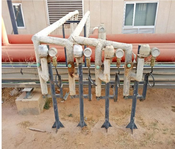
Figure IV.6 : Pressure Switch
