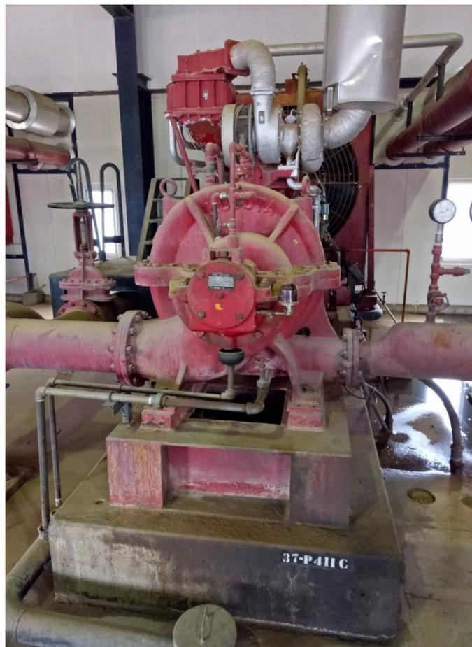
Figure IV.3 : Pompe anti-incendie P411C entrainées par moteur diesel
