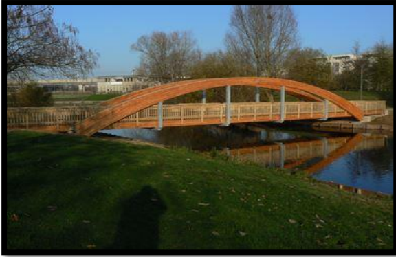
Figure 58 : Passerelles en bois de grande portée avec structure lamellé collée Source: http://www.marcanterra.fr/2-bois-plantes/159-passerelles-en-bois-de-grande-portee.html
