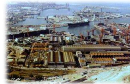
Le port de Dunkerque avant la requalification
