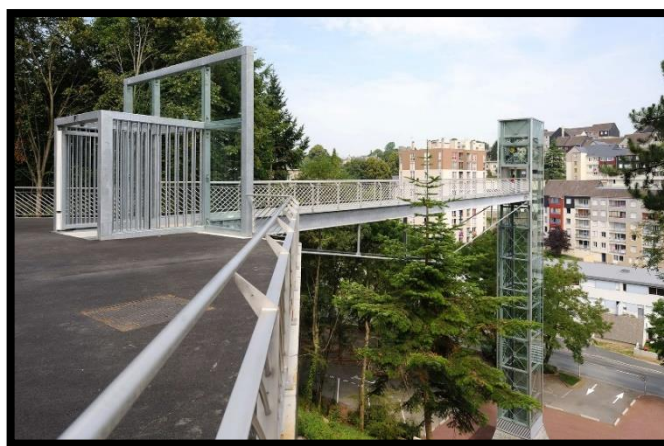
Figure 47 : Ascenseur urbain et passerelle piétonne Source: https://www.agenceschneider.fr/projets/ascenseur-urbain-passerelle-pietonne-saint-lo-50/
