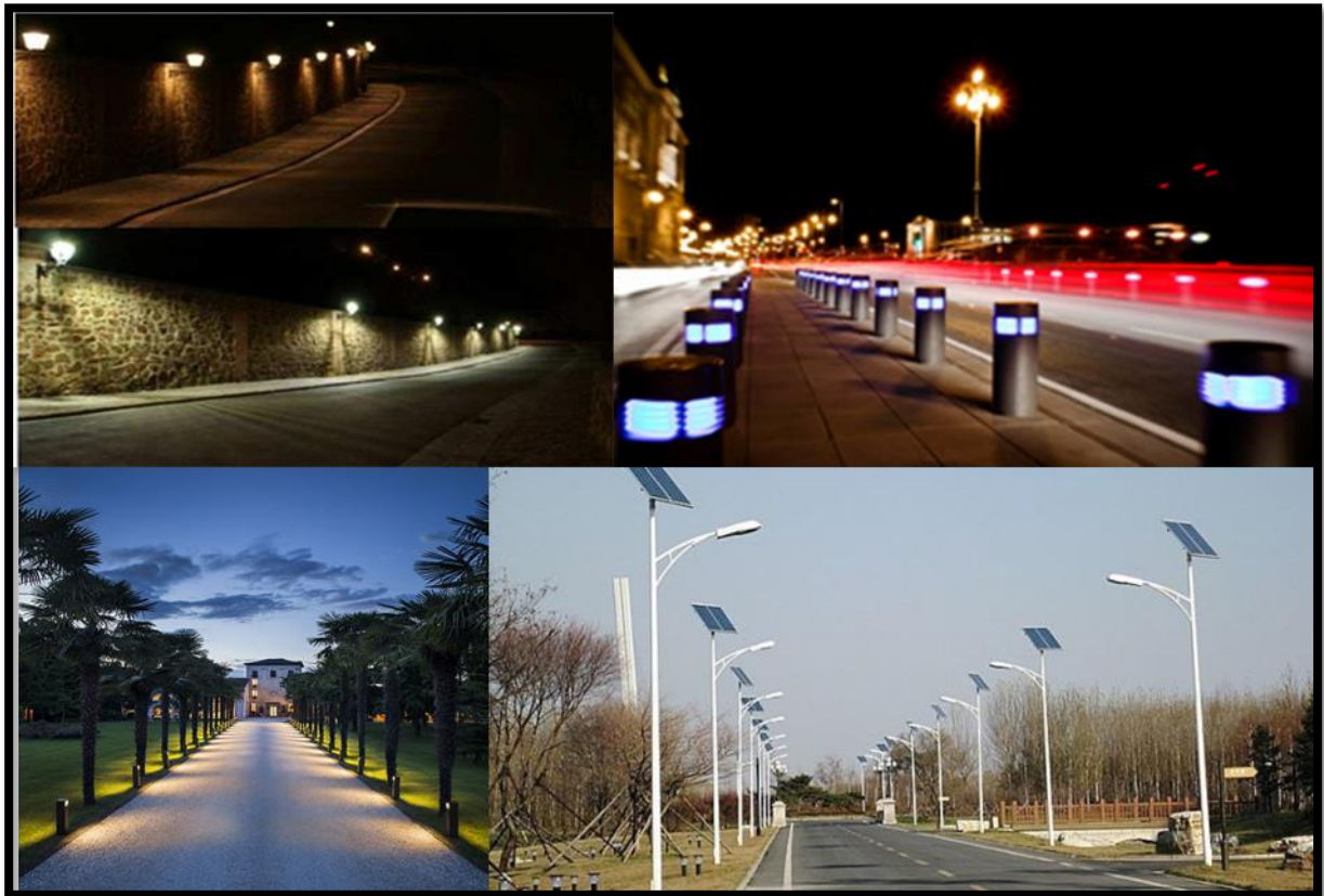
Figure 76 : éclairage public intelligent. Source : http://www.archiexpo.fr/
