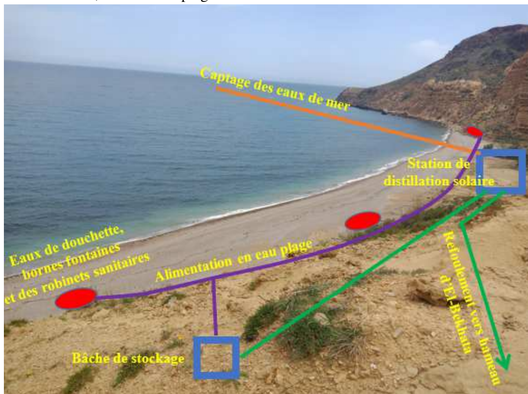
Figure 7.15 : Vue d'ensemble de l'installation du projet sur plage d'El-Bekhata
