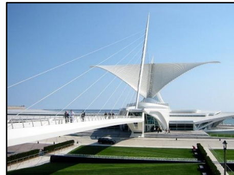
Figure 51 : Les ailes fonctionnelles comme brise-soleil.
