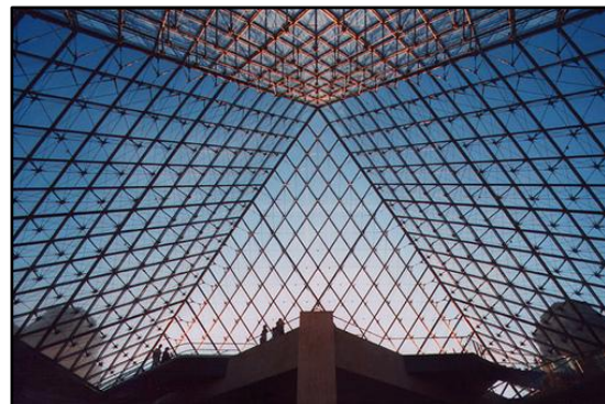
Figure 119 : système de construction du Louvre.
