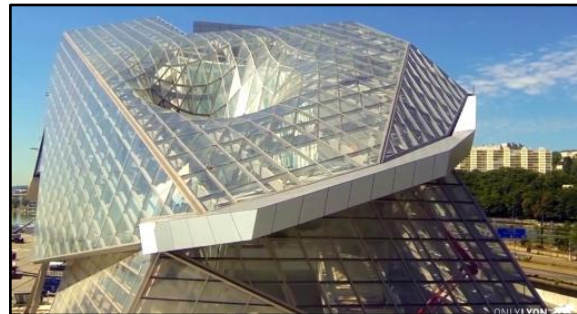
Figure 57 : La charpente métallique.
