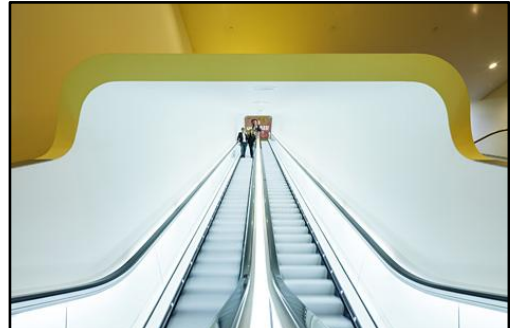
Figure 49 : Escalier mécanique de musée.
