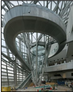
Figure 56 : Escalier roulant mécanique.
