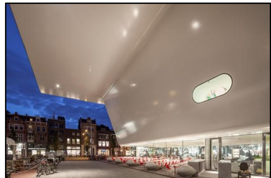
Figure 47 : Plafond Barissol pour l'absorption des résonances acoustiques.
