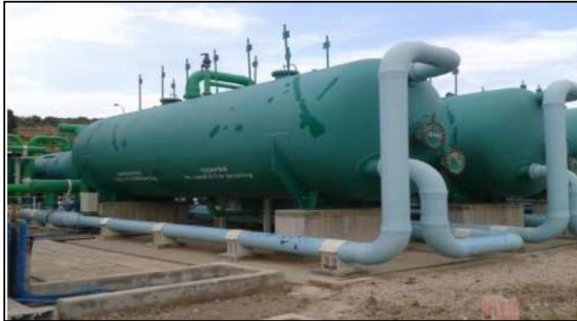
Photo.15 : Filtres à sables et anthracite (Source : station de Dessalement 'Honaine').
