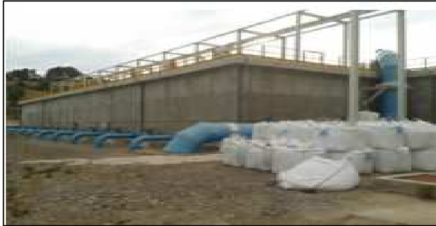
Photo. 19: Réservoir de l'eau dessalée (Source : station de Dessalement 'Honaine')
