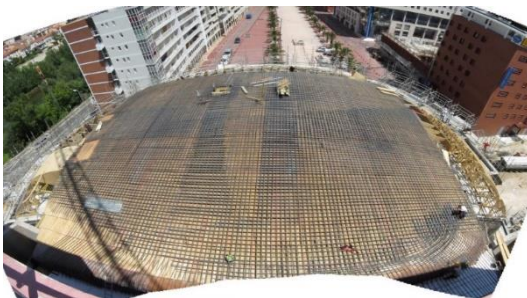
Figure 35: Coffrage d'une structure en coque
