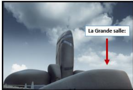
Figure 117 : façade de la grande salle.
