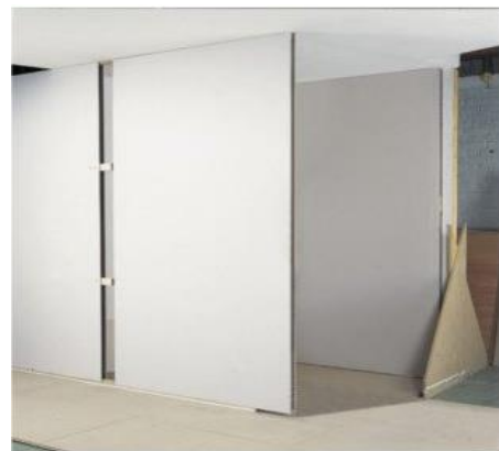
Figure 215 : cloison alvéolaire
