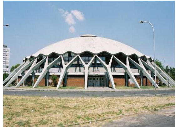
Figure 55 : façade de Palazzetto Dello Sport
