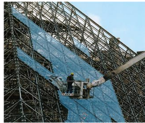
Figure 18 : Schéma de la structure en acier de la pyramide principale. A gauche: des tubes en acier de forme rhomboïdale avec des câbles et des raidisseurs. Droite: Les étapes de l'installation du verre sur la pyramide
