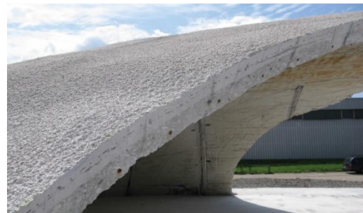
Figure 34 : Coque en béton
