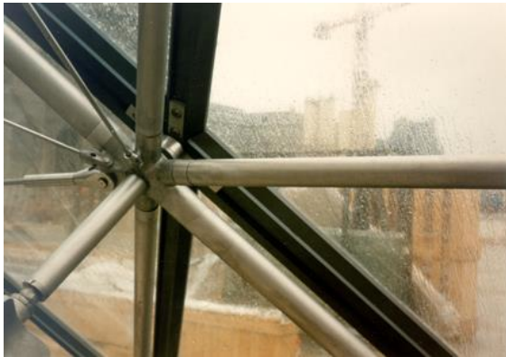
Figure 17 : pièce moulée d'assemblage des membrures extérieures
