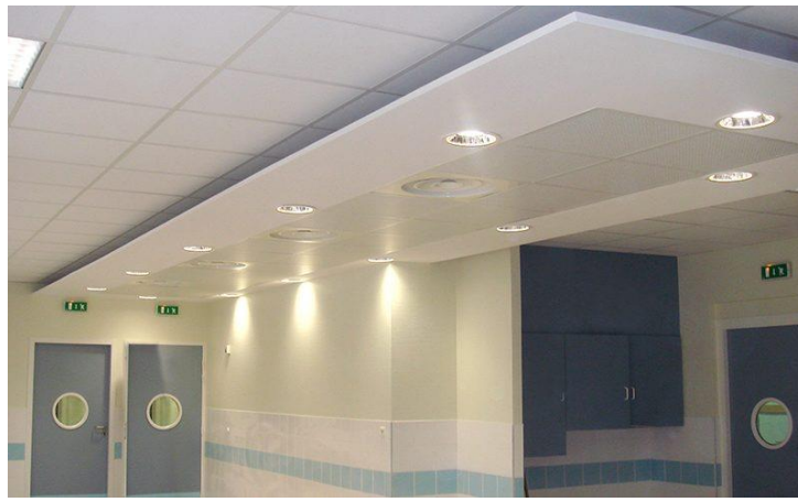
Figure 223 : faux Plafond suspendu.
