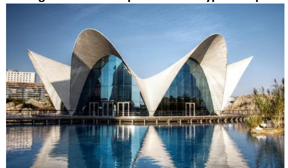
Figure 48 : forme paraboloïde hyperbolique
