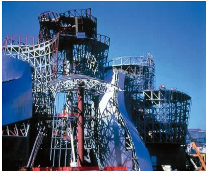
Figure 69 : Un treillis pour toute la structure
