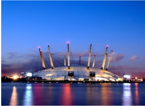
Figure 27 : Dôme du millénaire à Londres par richard Rogers, structure mariant membrane et résille de câbles, dans rigidifie le tissu en tension.
