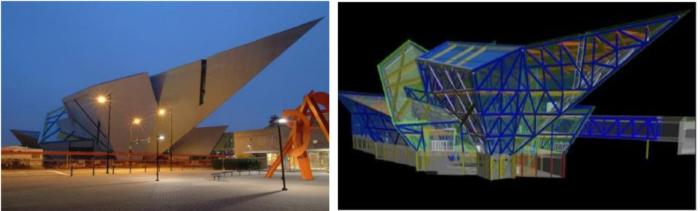
Figure 77 : structure en couverture
