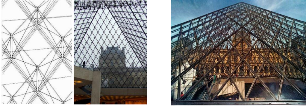
Figure 15 : poutres à treillis parallèles aux arêtes
