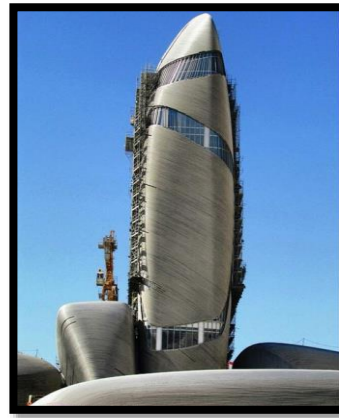
Figure 108:Façade en acier 350 km tubes en acier inoxydable 3D-incurvée
