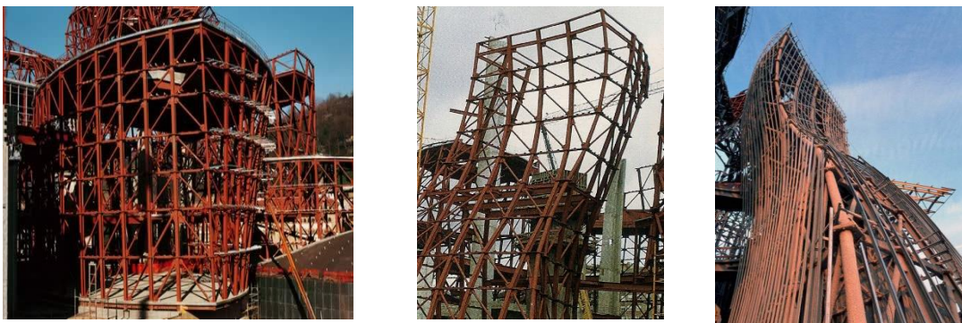
Figure 70 : la couverture métallique de forme onduleuse
