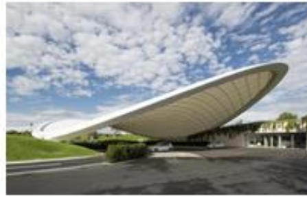
Figure 30 : pavillon de toiy de service autostrade de Volkswagen
