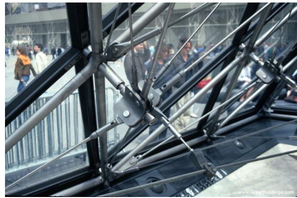
Figure 16 : pièce en mécano-soudé d'assemblage de membrures intérieures
