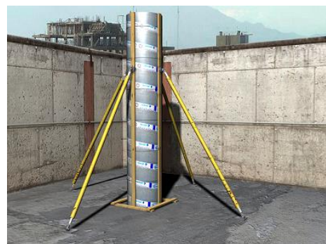
Figure 193 : Coffrage des poteaux cylindrique
