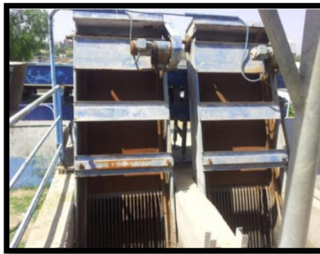
Figure 22 : dégrilleur fin
