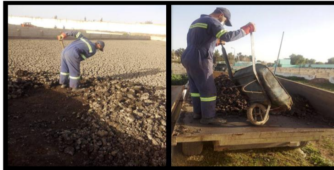
Figure 18 : Travaux d'évacuation des lits de séchage
