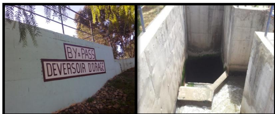
Figure 31:déversoir d'orage
