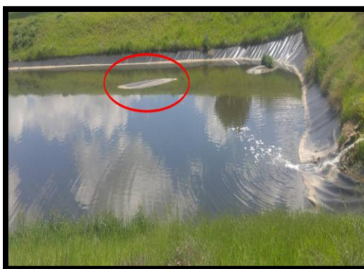
Figure 23 : gonflement de la géo-membrane Figure 24 : détachement de la géo- membrane
