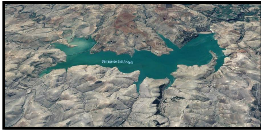
Figure 24 : le barrage de Sidi Abdelli [5].
