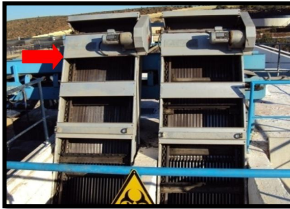
Figure 6 : dégrilleur mécanique
