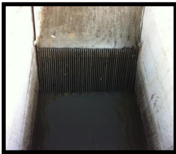
Figure11:grille de by-pass
