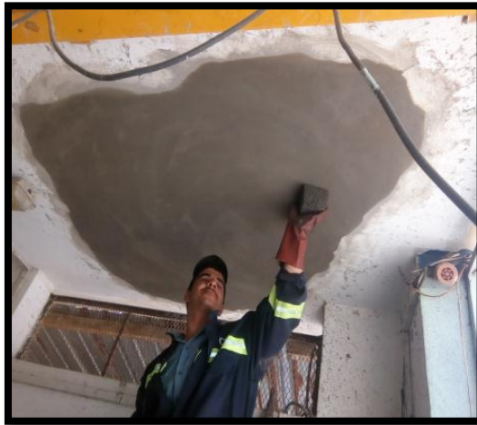
Figure 16 : travaux de finissage du plafond au niveau du local des pompes SR
