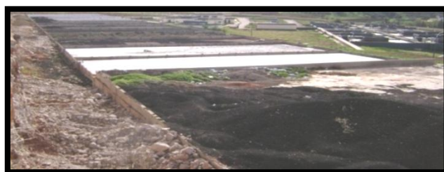
Figure 23: les 14 lits de séchages
