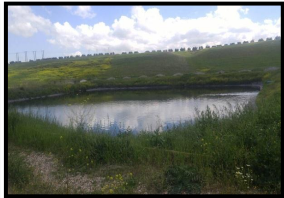
Figure 59 : bassin de maturation N°2
