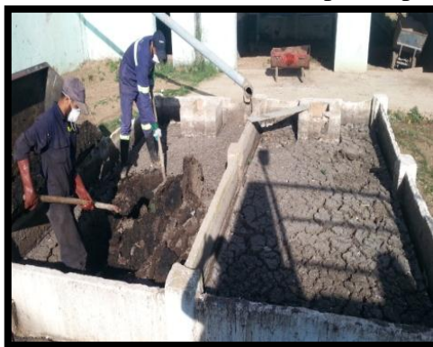
Figure 9 : Travaux d'évacuation des bacs à sable
