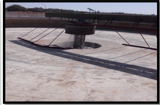
Figure 42 : décanteur vide
