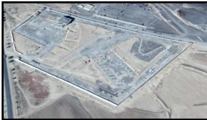
Figure 7 : le chantier de la STEP par satellite [5].
