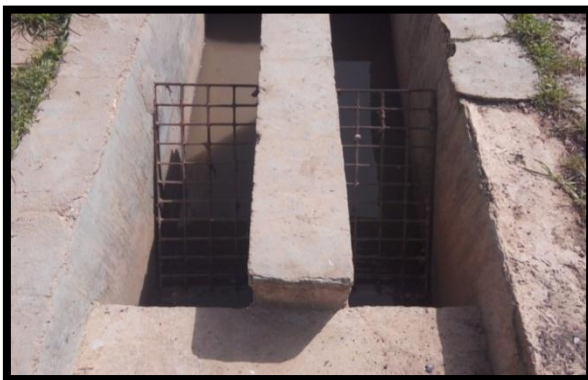
Figure 52 : dégrilleur fin
