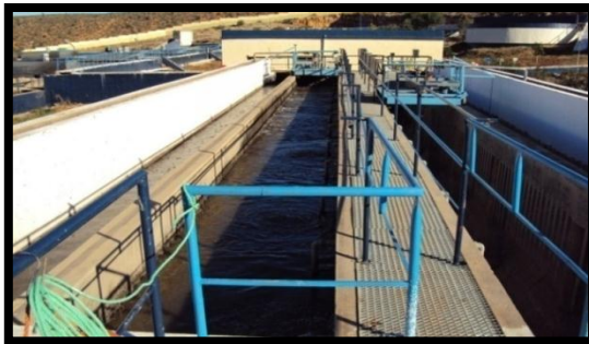
Figure 14:dégrossisseur-déshuileur
