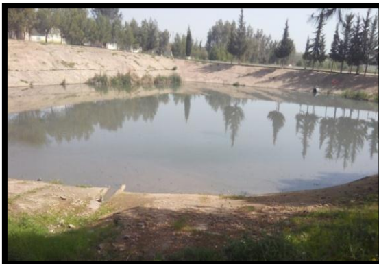
Figure 54 : bassin anaérobie N°1
