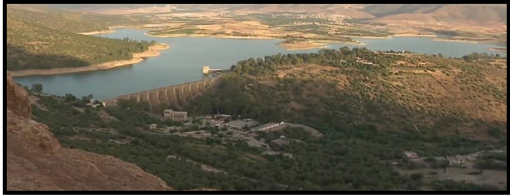
Figure 8 : barrage de Bèni Bahdel et son environnement voisin [16].
