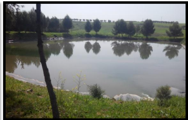
Figure 55 : bassin anaérobie N°2
