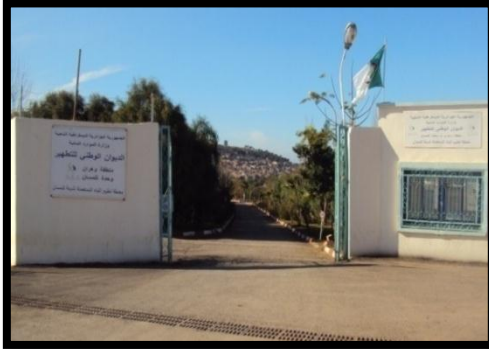
Figure 4: entrée de la STEP
