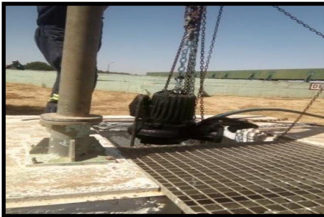
Figure 28 : remontage de la pompe de soutirage des boues P07
