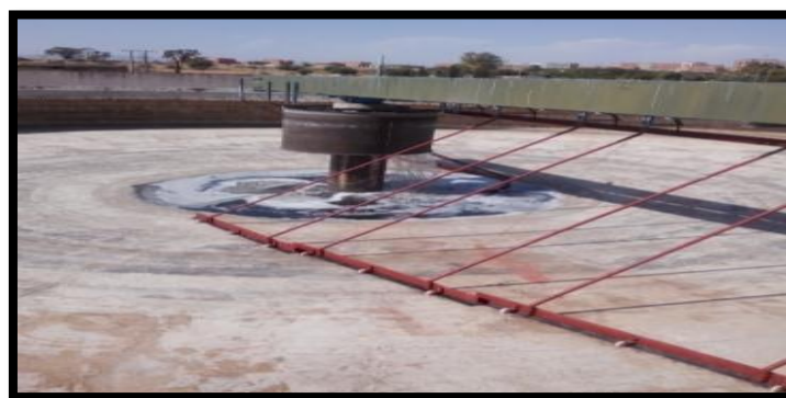
Figure 20 : décanteur N° 2 vide
