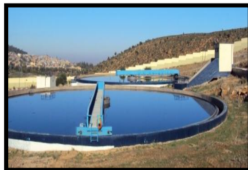
Figure 18: décanteur
