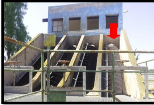
Figure 21 : vis d'Archimède
