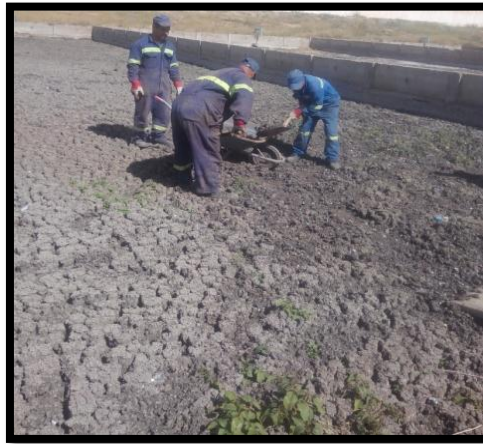
Figure 10 : Travaux d'évacuation des lits de séchage.
