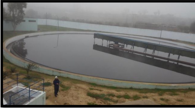
Figure 41 : décanteur secondaire
