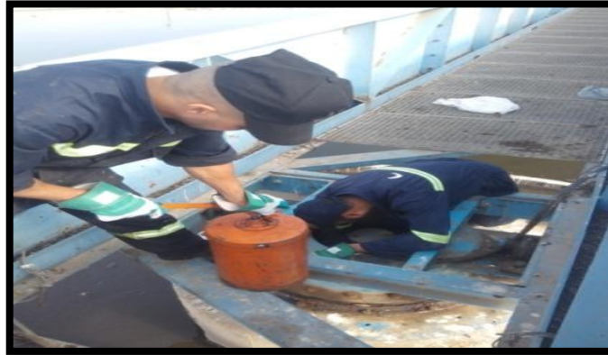
Figure 29 : Graissage des roulements
