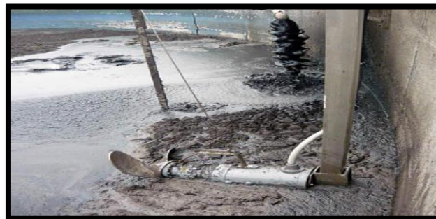
Figure 19 : le mélangeur de fond submersible
