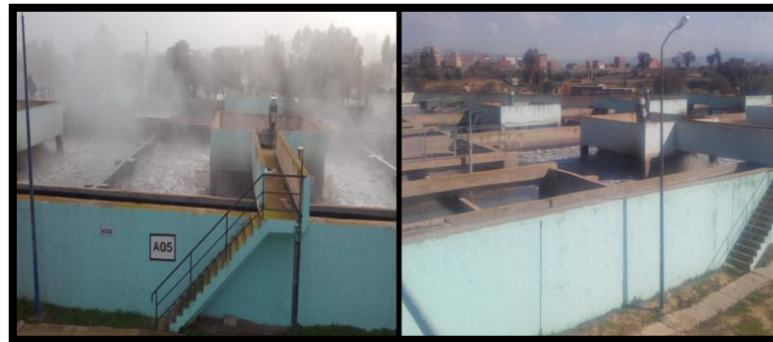
Figure 39 : bassins d'aération et de dénitrification
