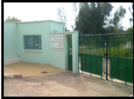
Figure 29:entrée de la STEP
