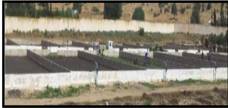
Figure 45 : les 14 lits de séchage
