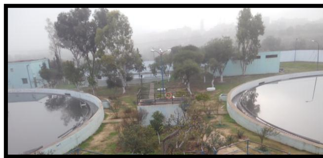
Figure 40 : tour de répartition
