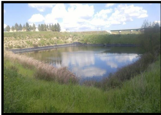
Figure 58 : bassin de maturation N°1
