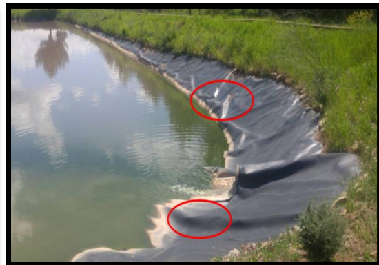
Figure 23 : gonflement de la géo-membrane Figure 24 : détachement de la géo- membrane
