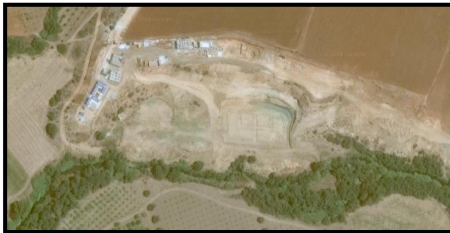
Figure 3 : image de satellite du chantier de la STEP [5].
