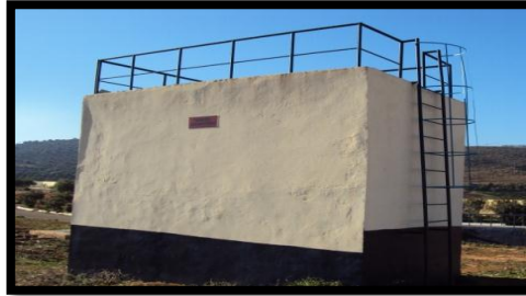
Figure 17: Tour de répartition
