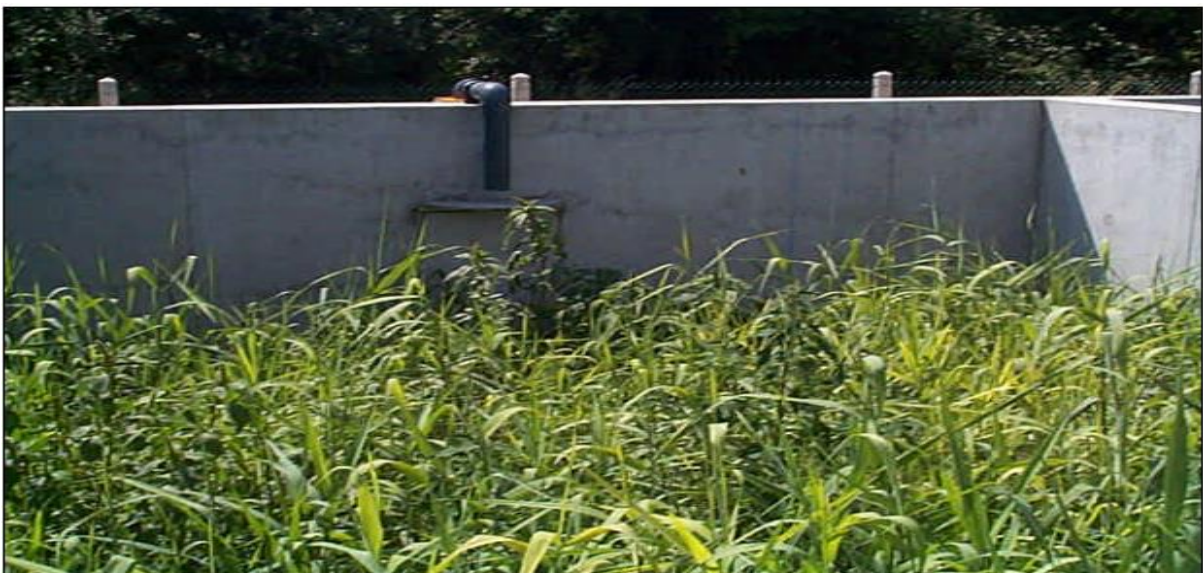
Figure 33 : lit de séchage planté de roseaux [38].
