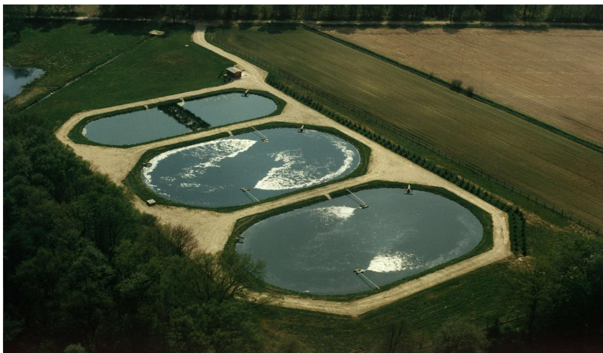
Figure 13 : image montrant la vus de dessus de lagunage aéré [34]
