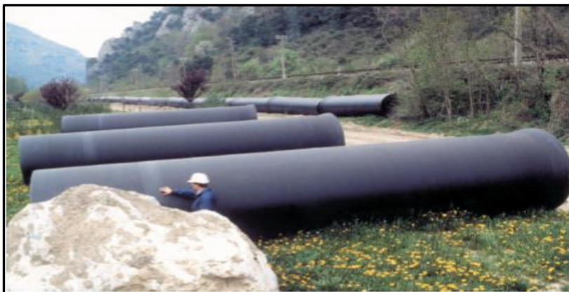
Figure IV.24 : Conduite en fonte ductile.
