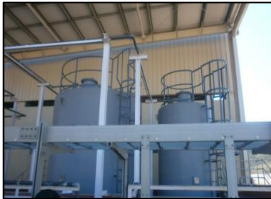
Figure III.12 : Chambre d'admission d'eau de mer.
