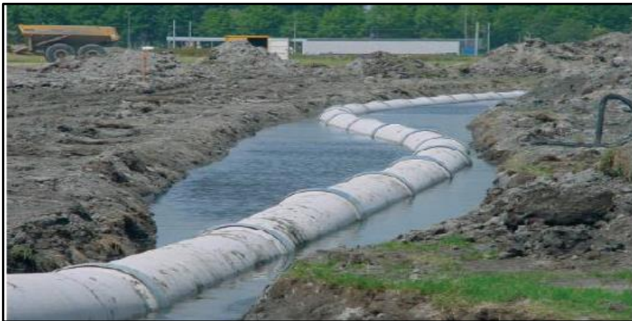
Figure IV.25. : Canalisation en fonte ductile revêtue extérieurement en mortier de ciment
