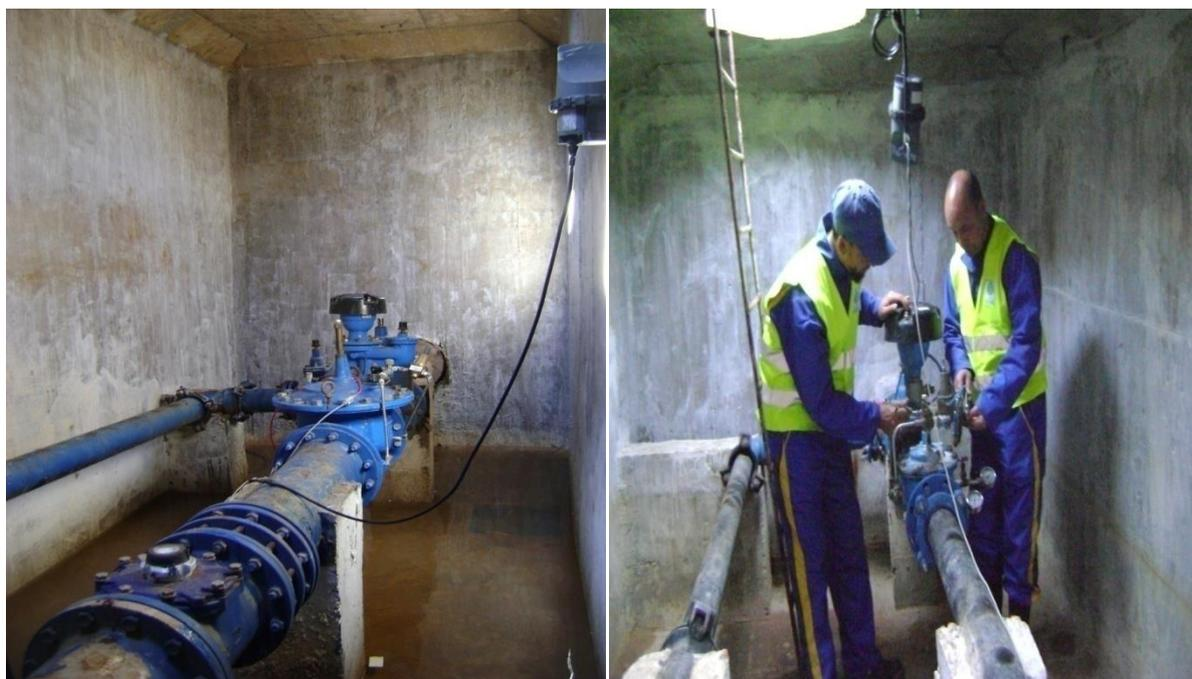
Figure IV-8 Chambre réelle de sectorisation (N Brachemi, 2017)
