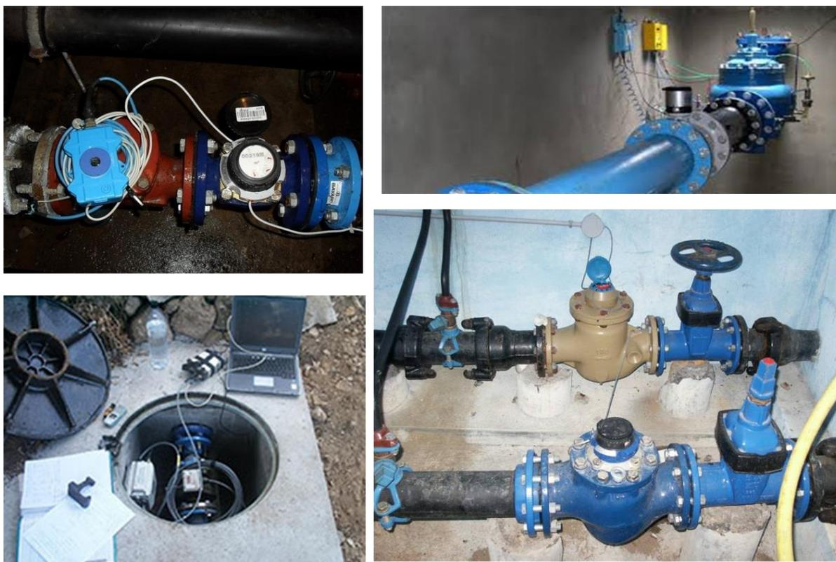
Figure I- 10 : Point de contrôle en sortie de réservoir. (N Brachemi, 2017)
